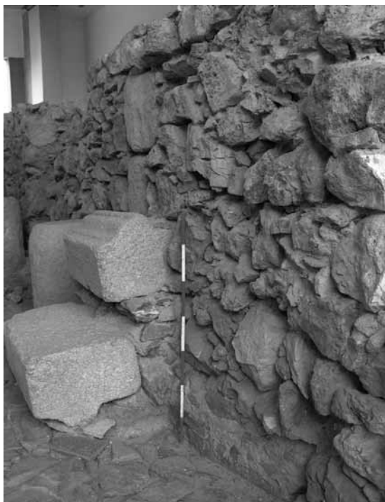
FIG. 12.- Piedra calcárea en el mampuesto y sillares para la trabazón de los cimientos (y muros).
