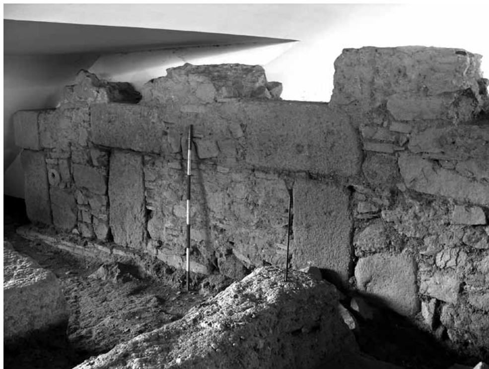
FIG. 16.- Cimentación de opus africanum (edificio "C").
