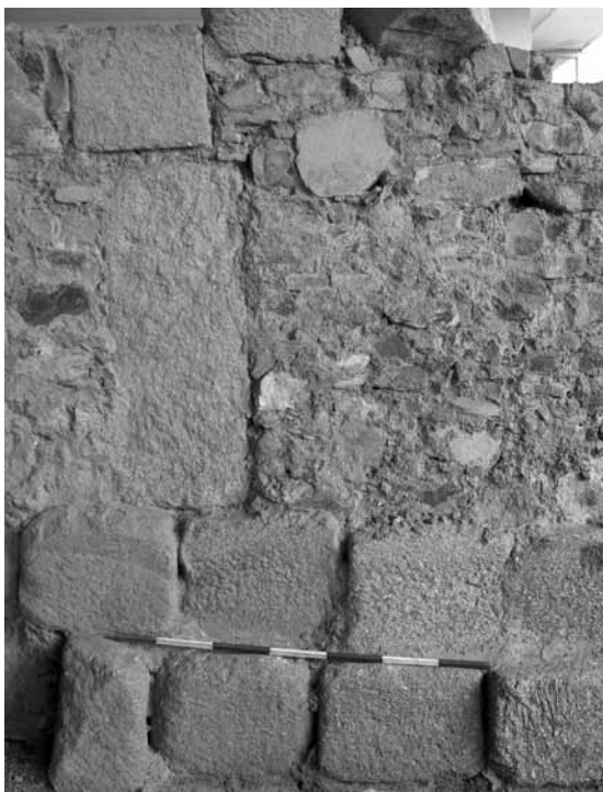
FIG. 15.- Detalle del esmerado careado del cimientto, profundidad de 3 m y doble línea de sillares en la base (edificio "C").
