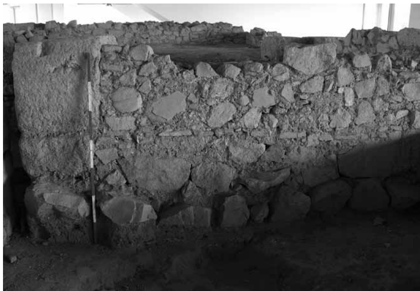
FIG. 22.- Mampostería sobre basamento de grandes piedras (y sillares de refuerzo en las esquinas).
