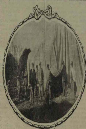
Fumigación de gas clorhidrico en las uñeras
