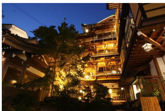
Fig. 100. Fotografía del onsen de Kanaguya
