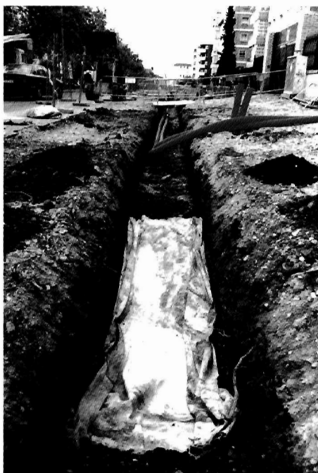
LÁMINA VIII: Proceso de protección con geotextil ed Estructuras Arqueológicas para su conservación 'in situ'.
