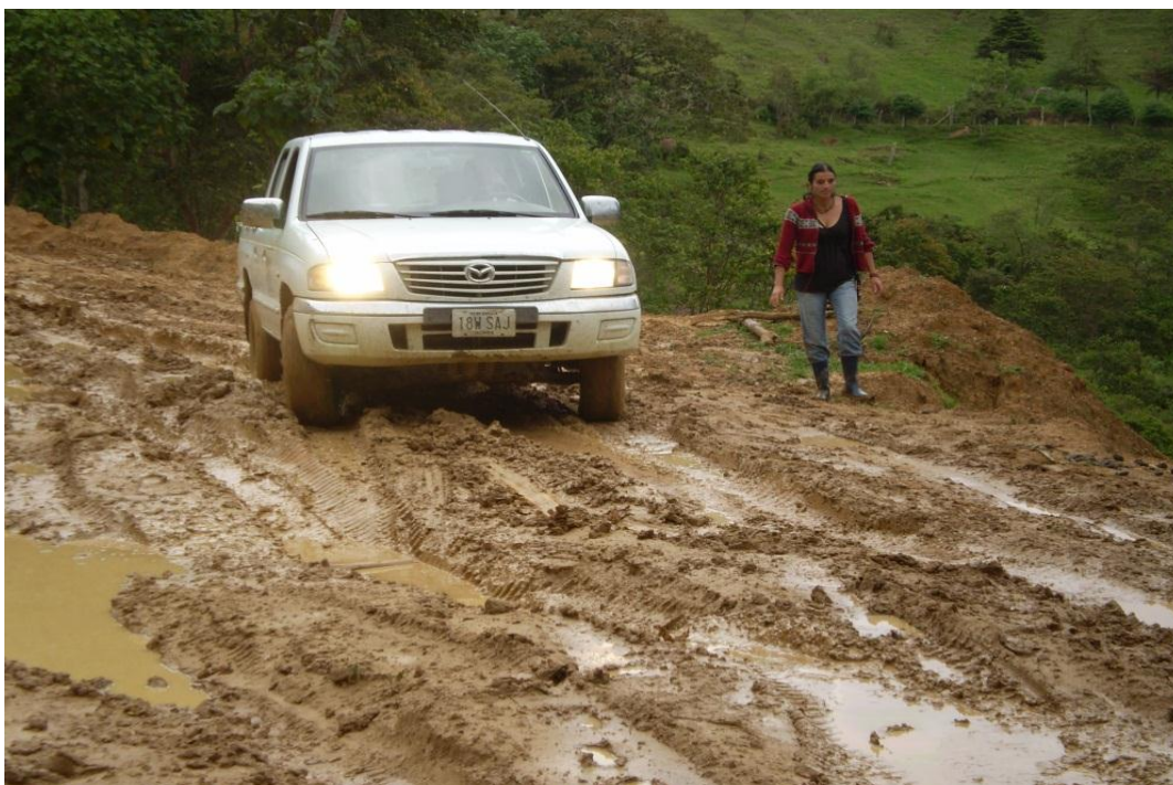
Fotografía 1. Vista de Carretera hacia la Loma de Mocayes en temporada de lluvia. Propia. Sep. 2009
