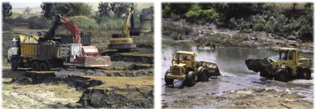
Figura 2. Labores de retirada mecánica de los lodos en la llanura de inundación (izquierda) y posteriormente del cauce (derecha). © Consejería de Medio Ambiente, Junta de Andalucía.
