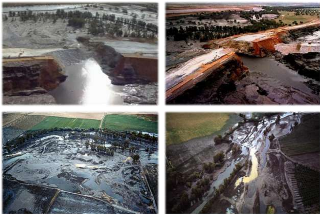
Figura 1. Fotografías que muestran la rotura del muro de la balsa de estériles que almacenaba la empresa Boliden-Apirsa S.L. en Aznalcóllar (arriba) y la extensión de los lodos tóxicos y aguas ácidas por el río Guadiamar (abajo). © Consejería de Medio Ambiente, Junta de Andalucía.
