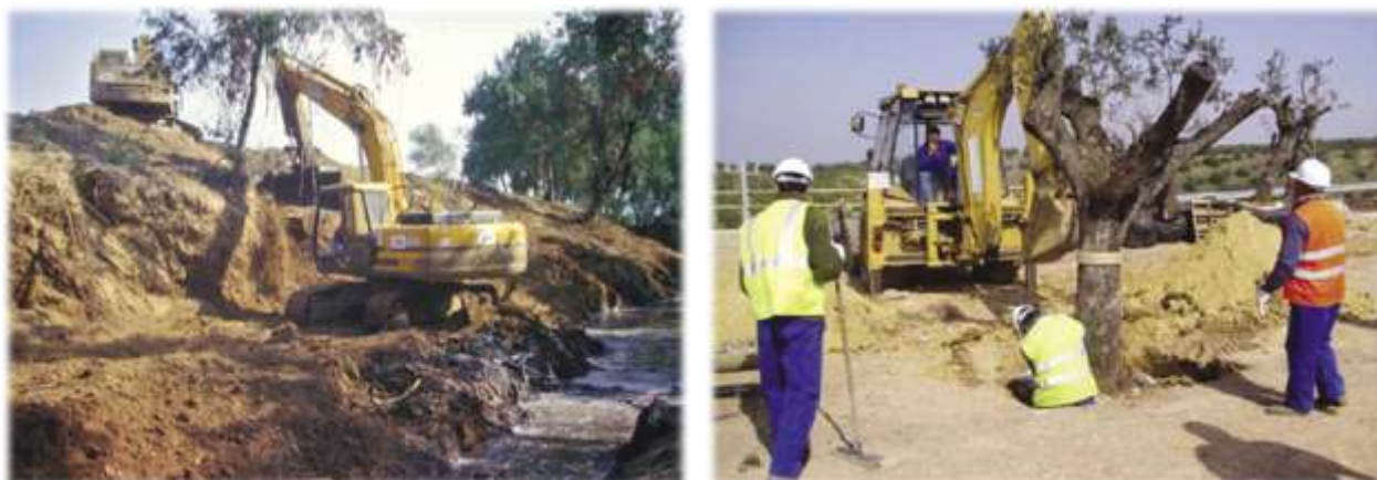
Figura 3. Labores de acondicionamiento de taludes (izquierda) y trabajos de reforestación (derecha). © Consejería de Medio Ambiente, Junta de Andalucía.
