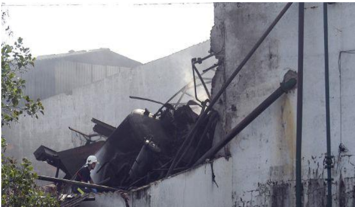
Figura 7: Efectos explosión caldera en una almazara de Moraleja (Cáceres) 2012.
