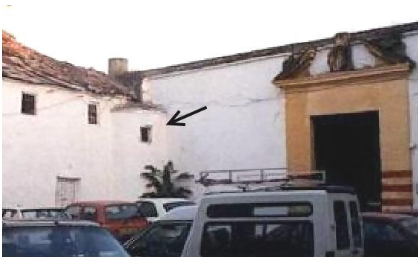
7. Detalle de la ventana del partidor de la plaza Badanas (Gerencia de Urbanismo de Córdoba)
