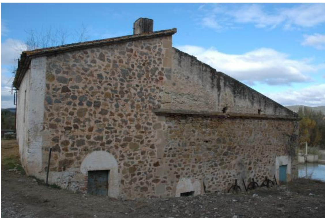
Fig. nº 17 .- Edificio que albergaba las turbinas. Estado actual. 54
