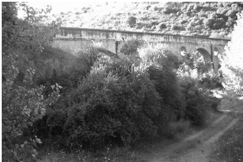
LÁM. 21: Canal del Albolote. Tramo sobre arcos en el Río Blanco.
