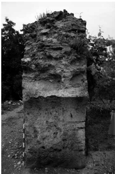
LÁM. 16: Arco fragmentado de la subestructo del acueducto de Calicasas donde aparece amortizado en el recrecimiento posterior la caja del canal romano propiamente dicho.
