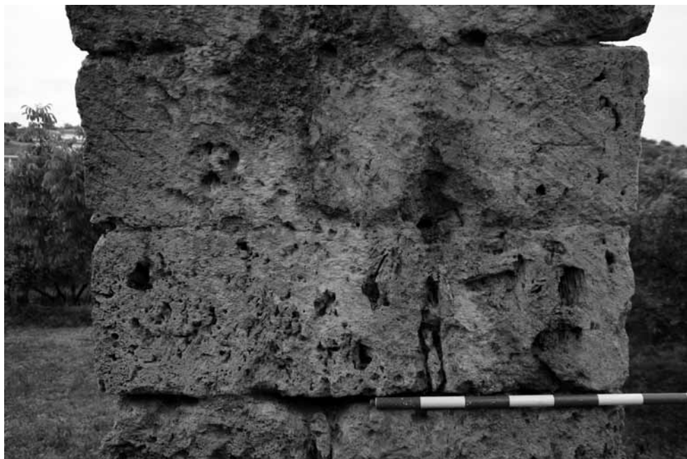
LÁM. 15: Marcas de cantero en el intradós del arco del Acueducto de Calicasas.
