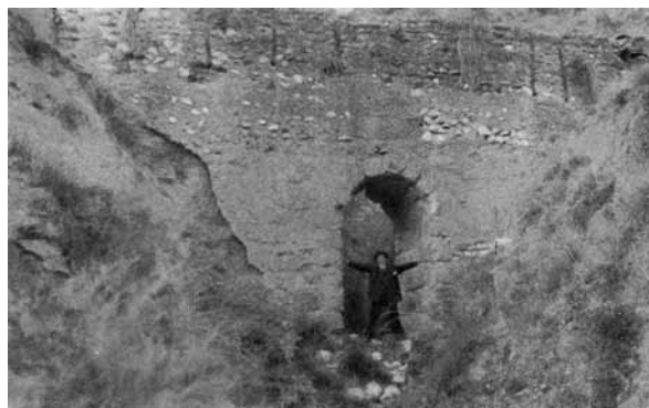
LÁM. 10: Substructio del acueducto sobre el barranco de La Umbría del Moral I. Tramo IV. Foto: Fernández Casado (1972).
