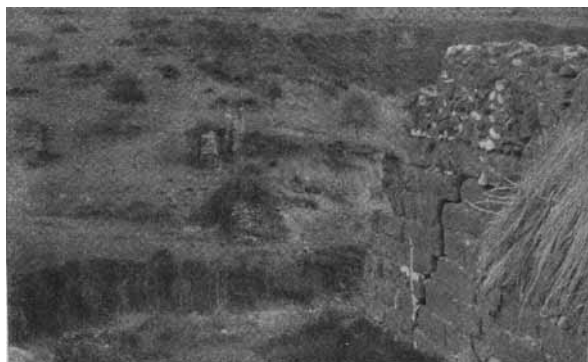
LÁM. 22: Substructio de sillares que atraviesa perpendicularmente una vaguada (Posiblemente sobre el Río Blanco o en el Arroyo de Vitar). Foto: Fernández Casado (1972).
