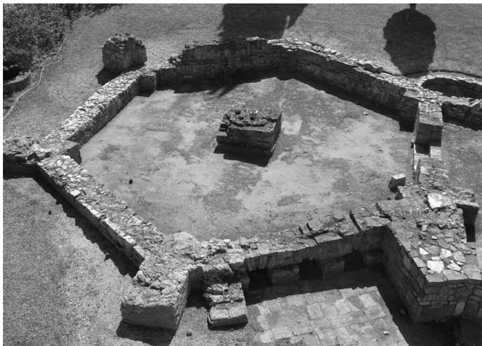
FIG. 9 - Torreão nascente do Cerro da Vila
