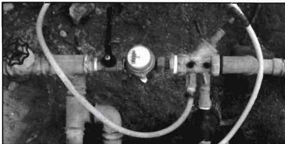
Sería muy conveniente que las instalaciones de riego localizado tuviesen algún sistema de medida del agua aportada (válvula volumétrica, contador, como en la foto); caso contrario, se deberían aforar los goteros para conocer el agua aportada en función del tiempo de riego
