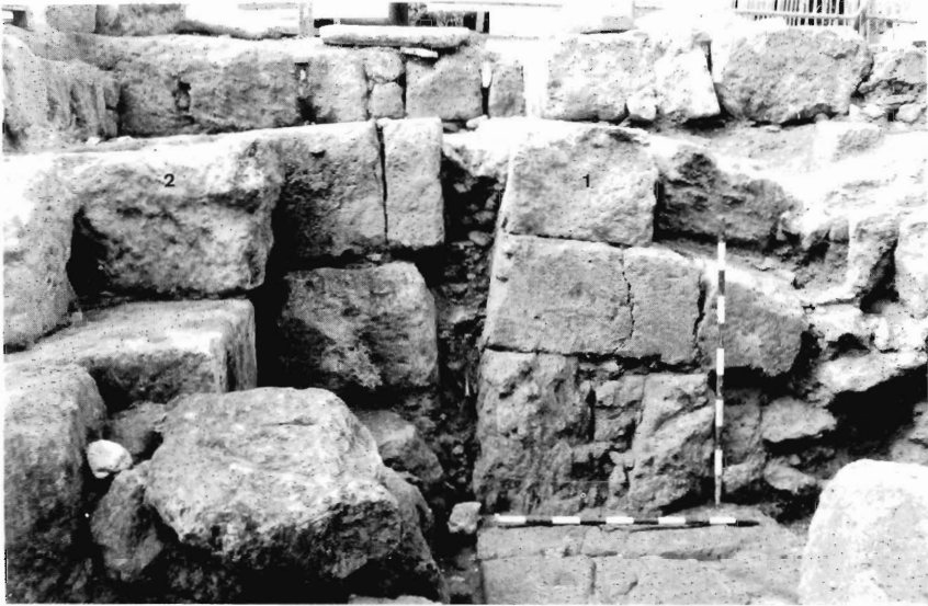
Lám. 3.- Detalle de la separación entre la muralla romana (1) y la hispanomusulmana (2).
