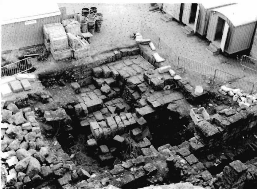
Lám. 6.- Murallas romana y árabe vistas desde el Norte.
