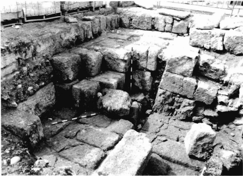
Lám. 9.- Detalle del aparejo empleado en la muralla hispanomusulmana documentada en la fosa de Escribano.
