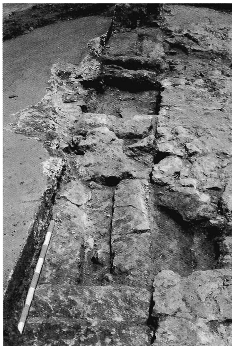
Lám. 4.- Aparejo del muro Sur de la Estancia III. Menos cuidado que el anterior aunque sigue la misma técnica constructiva.
