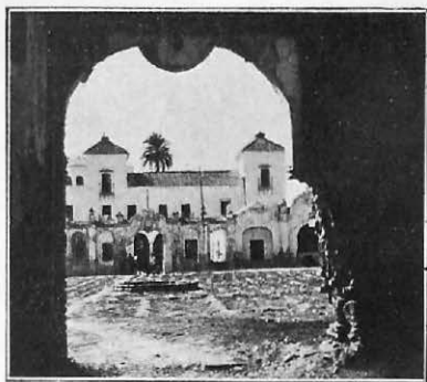
Edificio central.—Fachada principal
