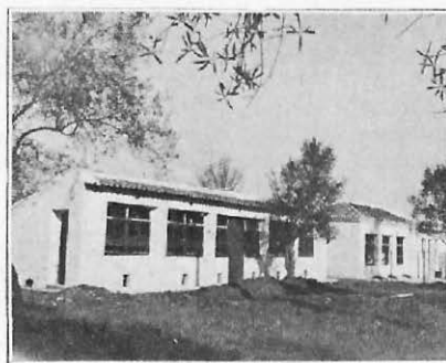
Vista general de la sala de incubación y cría de polluelos
