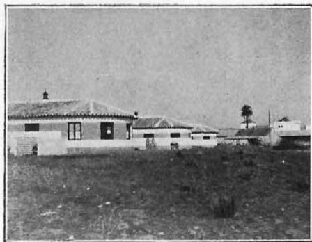
Vista general de la Sección de cerda
