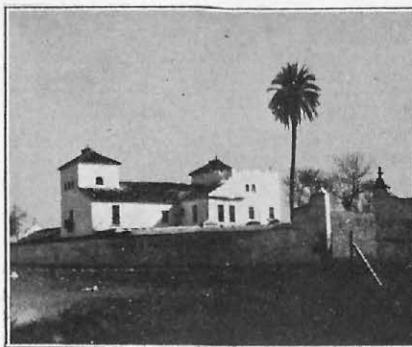
Edificio central.—Vista lateral
