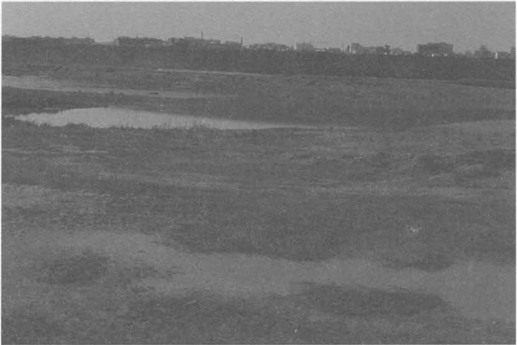
Fotografía 5.- Aspecto de la defensa del margen izquierdo en 1983.
