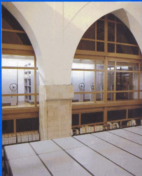
Depósito de documentos. Nave central de la antigua Iglesia.
