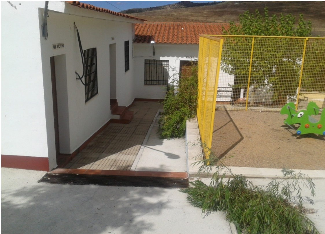
Figura 13. Vista de la fachada de la sede “SEP Espiel-Villaharta”
