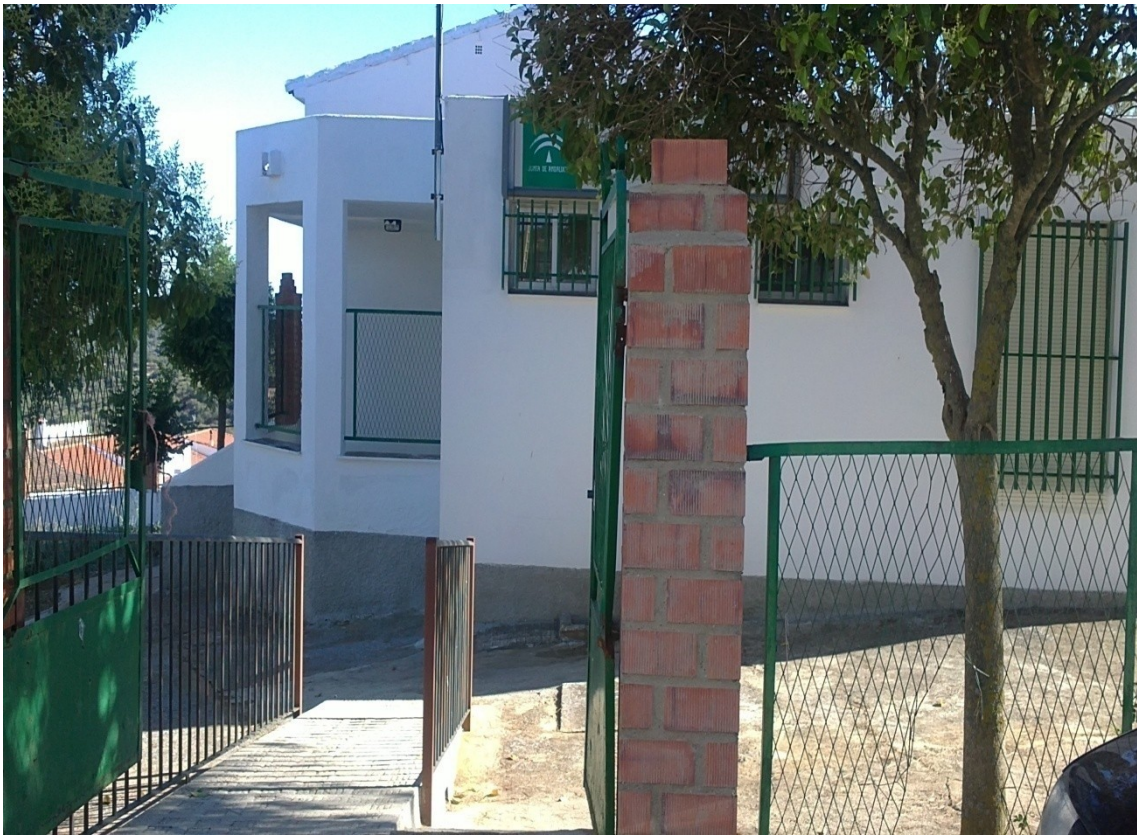
Figura 7. Vista de la fachada del Aula El Alcornocal
