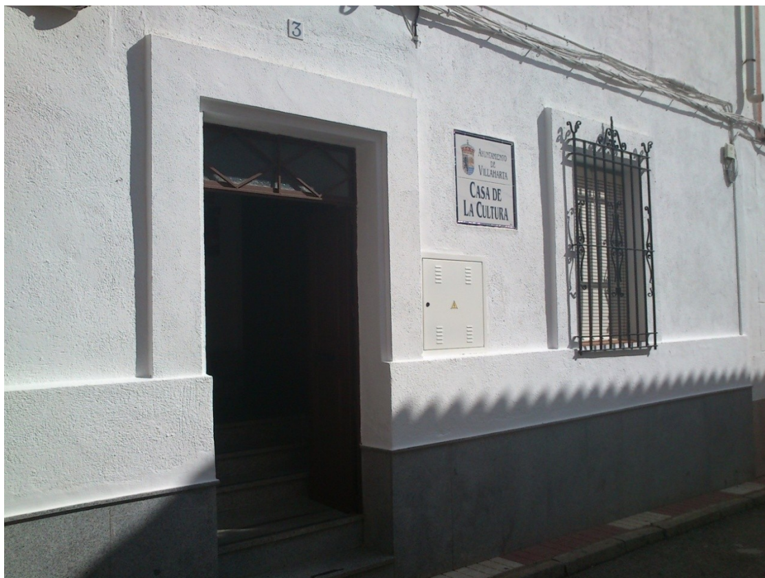
Figura 15. Vista de la fachada del “Aula Villaharta” - Edificio 2
