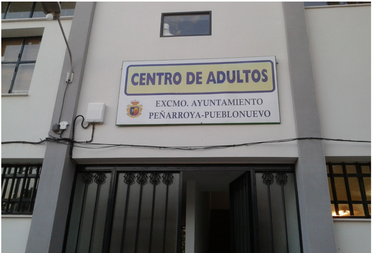
Exteriores de la “SEP Peñarroya-Pueblonuevo”
