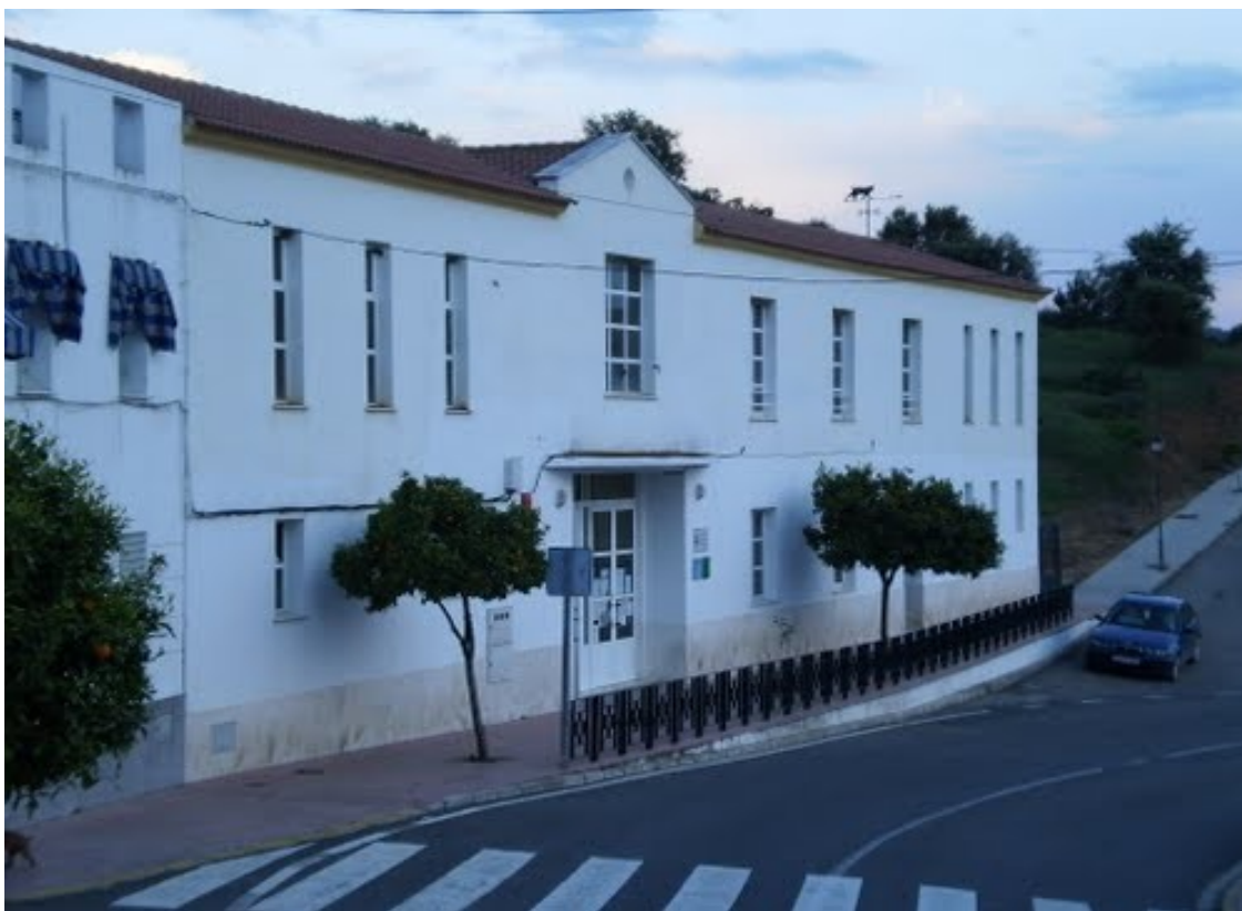
Figura 14. Vista de la fachada del “Aula Villaharta” - Edificio 1
