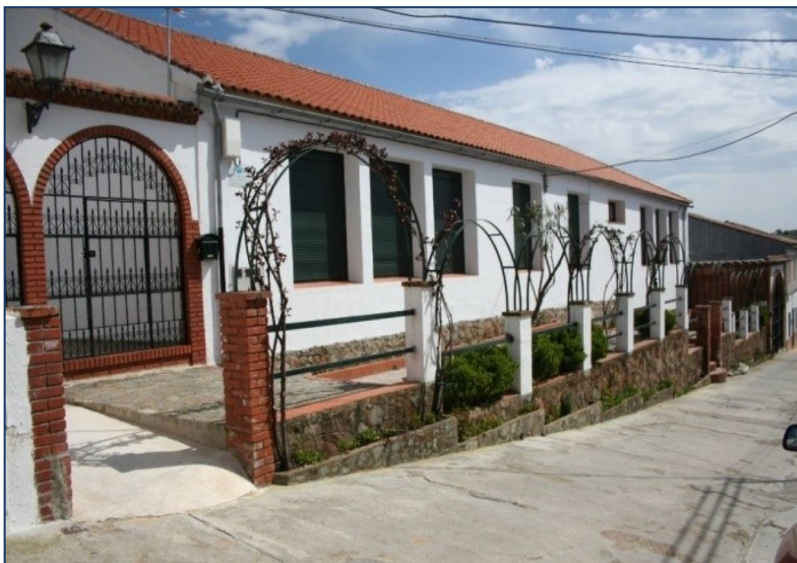
Figura 18. Vista de la fachada de la “SEP Villaviciosa de Córdoba”
