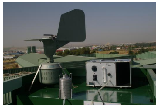
Figura 2.4. Captador instalado en el Edificio Celestino Mutis del Campus Universitario de Rabanales a unos 22 metros del suelo, en una prolongación de la escalera de incendios.
