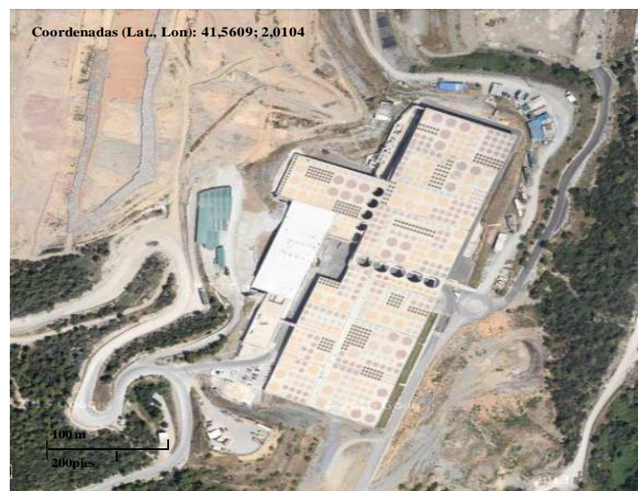
Figura 1.1. Planta de gestión de residuos del municipio de Vacarisses (Barcelona)
