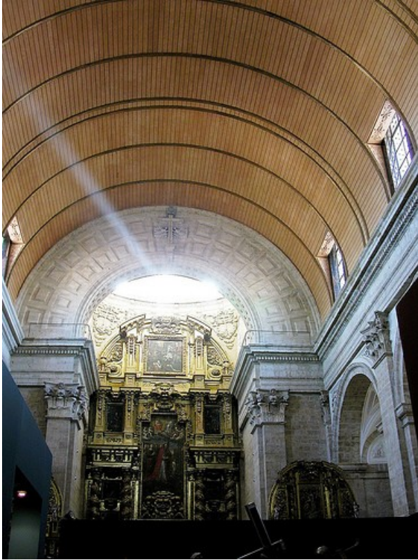
Figura 194 Iglesia tras la restauración http://farm4.staticflickr.com/3037/2978375446_2a09407268.jpg
