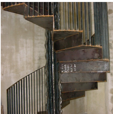
Figura 303 Pie estructural de la escalera de acceso a torre. . Foto del autor
