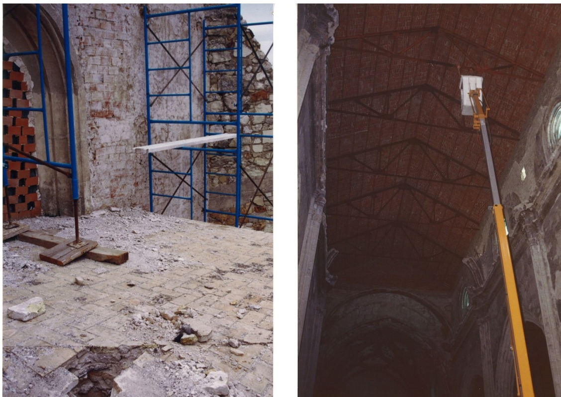
Figura 270 Catas practicadas y vehículo de reconocimiento en el interior de SMLM, el autor esta subido en la canastilla .Septiembre 1997
