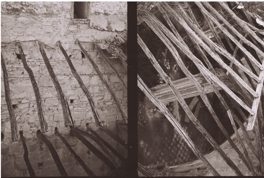
Figura 265 Cubiertas y restos de la estructura de madera ,tras el incendio Foto del arquitecto J. Antonio Gómez Luengo 1972
