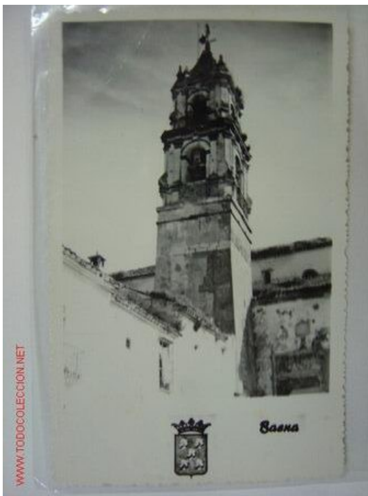
Figura 250 Torre y entorno urbano en Fachada Norte . http://t3.gstatic.com/images?q=tbn:ANd9GcSW5loHzHOGem1uLNoeR8yaYYvEAJTi0zf3ikvRhgSCeY_mLdOZsplaw
