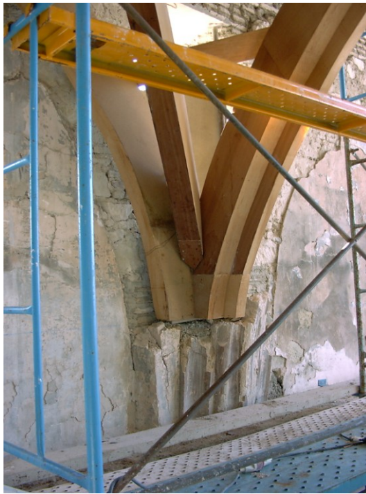
Figura 359 Experimentación de las técnicas de colocación de los distintos arcos en los nudos y sobre los restos de los arranques de las bóvedas barrocas. Foto del autor.
