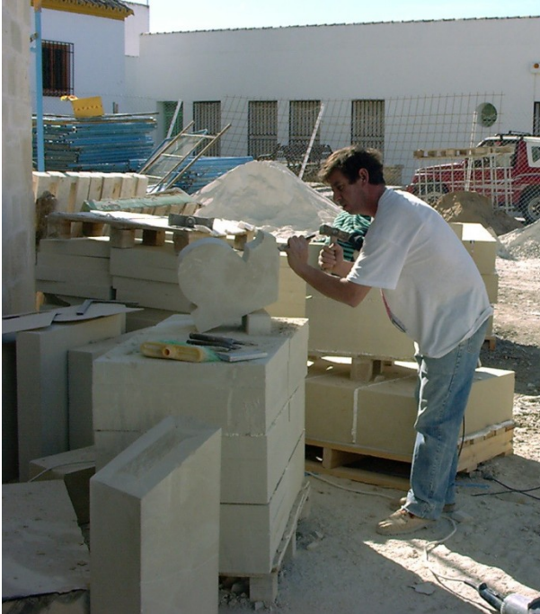
Figura 365 Cantero y artista esculpindo una pieza ornamental para la restauración de la portada del Ángel. Foto del autor.
