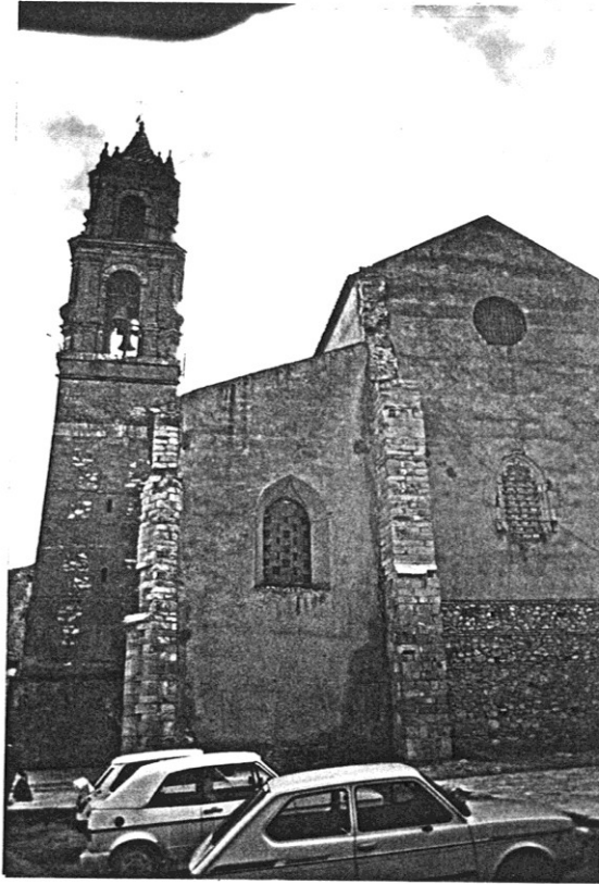
TORRE Y FACHADA OESTE
