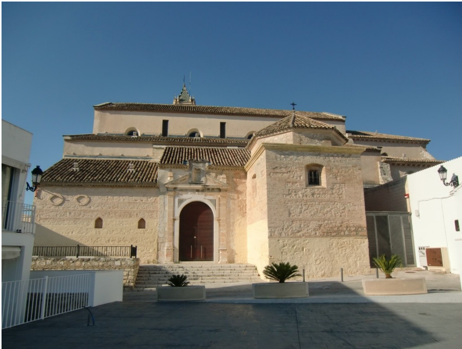
Figura 255 Foto del autor fachada Sur
