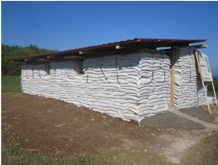
Figura 162 Refugio para Haití http://arquiefimeras.files.wordpress.com/2011/05/haiti.jpg
