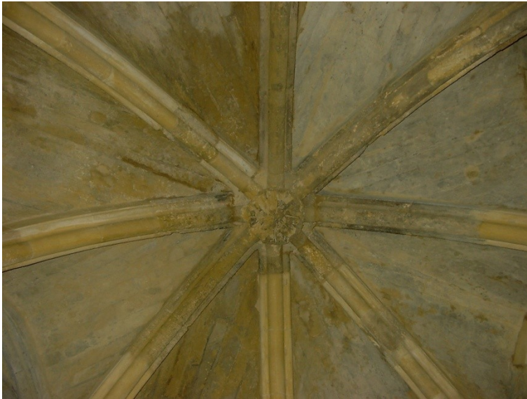
Figura 161 Restauración nervaduras de bóvedas .Alcázar de los Reyes Cristianos de Córdoba. Foto del autor
