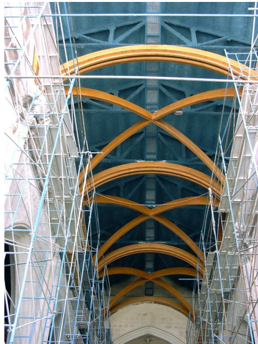
Figura 360 Disposición en obra de los primeros arcos de las bóvedas. Foto del autor.
