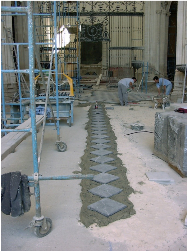
Figura 324 Materiales naturales utilizados en SMLM mármoles blancos y negros disposición en damero .Foto del autor.
