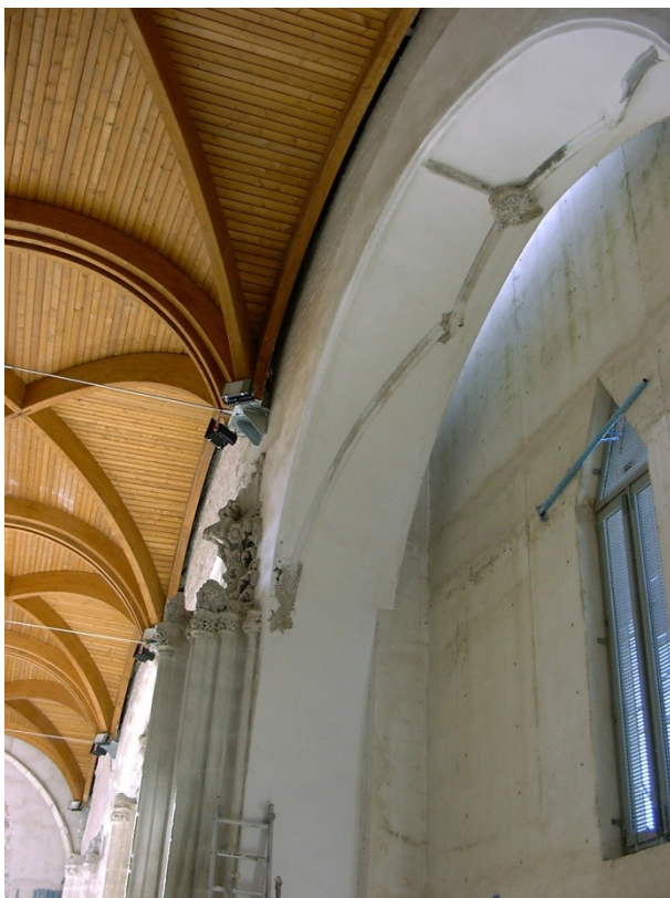
Figura 323 Materiales utilizados en SMLM madera laminada, hormigón blanco en los nuevos cerramientos. Capilla en nave del Evangelio .Foto del autor
