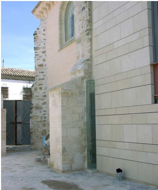
Figura 311 Encuentro entre contrafuerte y nuevo muro de cerramiento. Foto del autor
