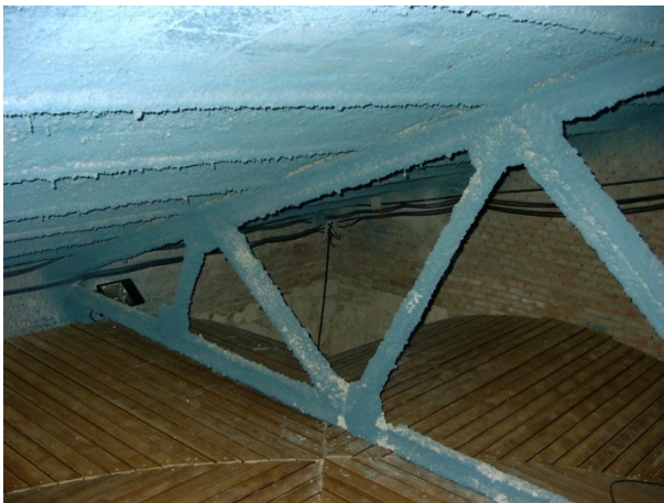
Figura 321 Materiales artificiales utilizados en SMLM morteros ignífugos .Foto del autor.
