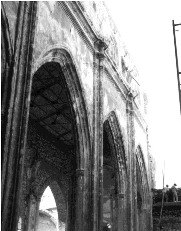
Figura 300 construyendo el muro de cerramiento del coro. Restauración tras el incendio de la Guerra Civil. Foto de J. Antonio Gómez Luengo
