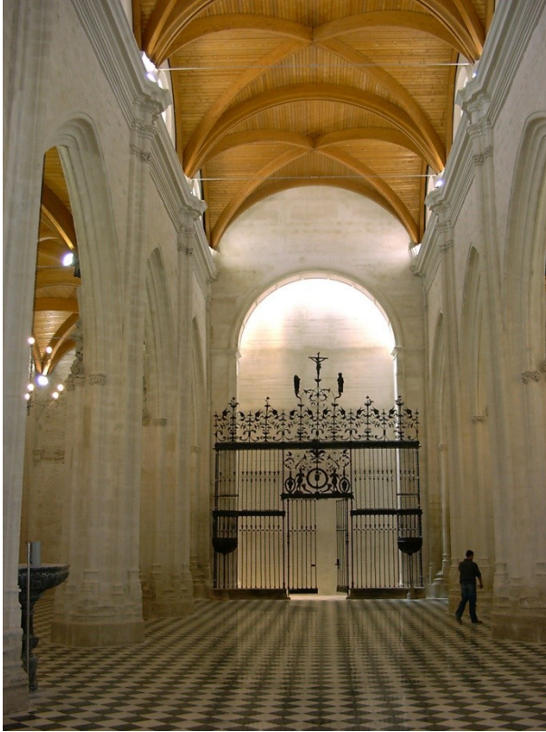
Figura 298 Muro de cierre del volumen perdido del coro tras la intervención de restauración con la verja del presbiterio trasladada.
