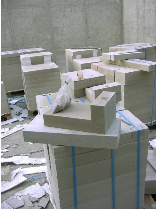
Figura 322 Materiales naturales utilizados en SMLM areniscas en los nuevos cerramientos .Foto del autor
