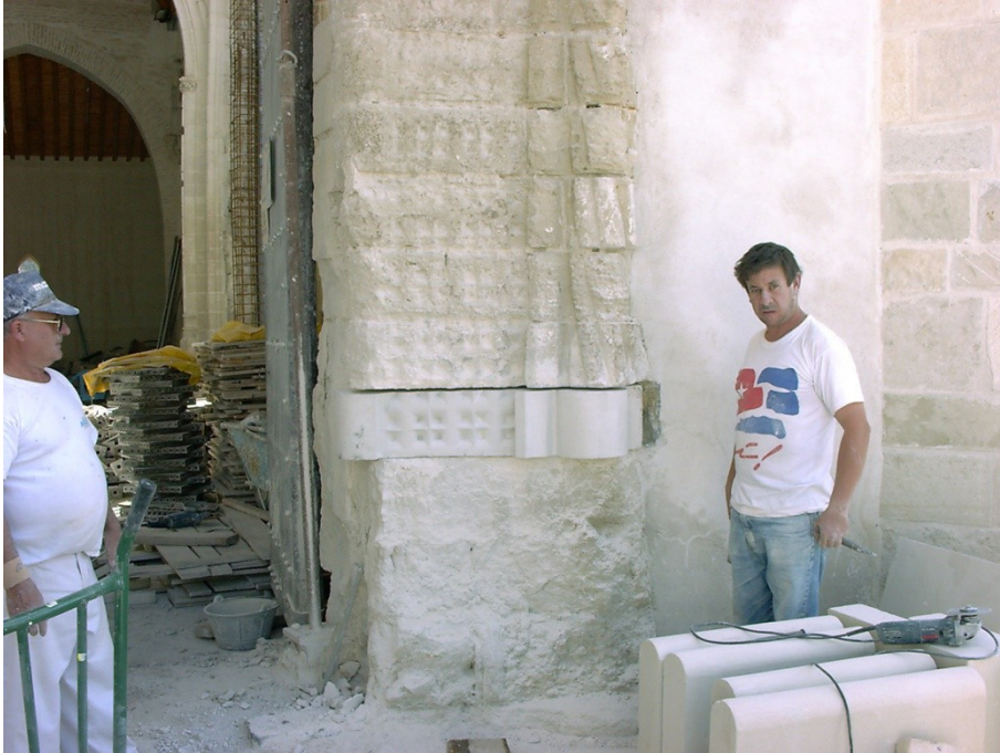
Figura 363 Pruebas y experimentación de piezas unitarias de cantería ,para la restauración de la Portada del Ángel. Foto del autor
