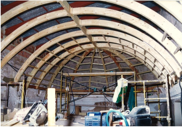
Figura 195 Construcción bóvedas Capilla Orden Tercero foto del autor
