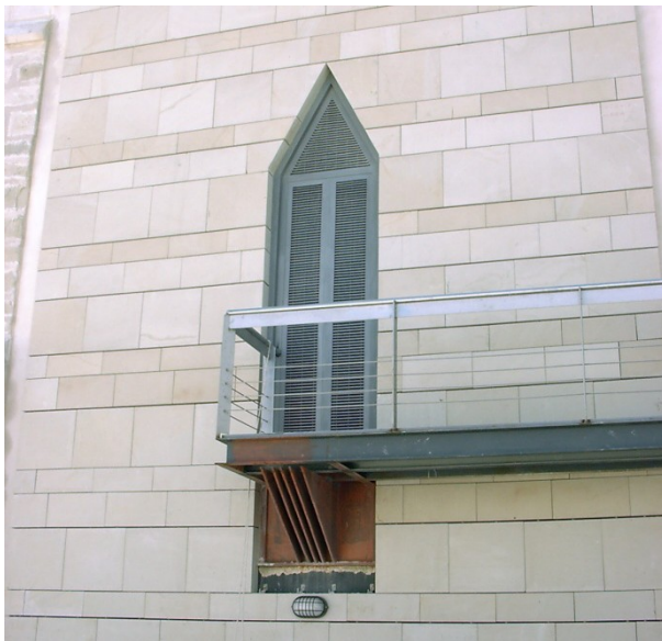
Figura 305 Exterior, pasarela de acceso a torre. Foto del autor en fase de obra.
