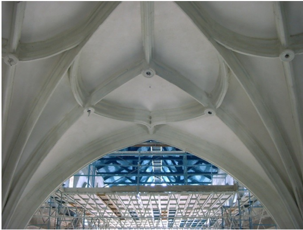
Figura 320 Materiales naturales en SMLM piedras utilizadas en la restauración de las bóvedas nervadas del presbiterio. Foto del autor.
