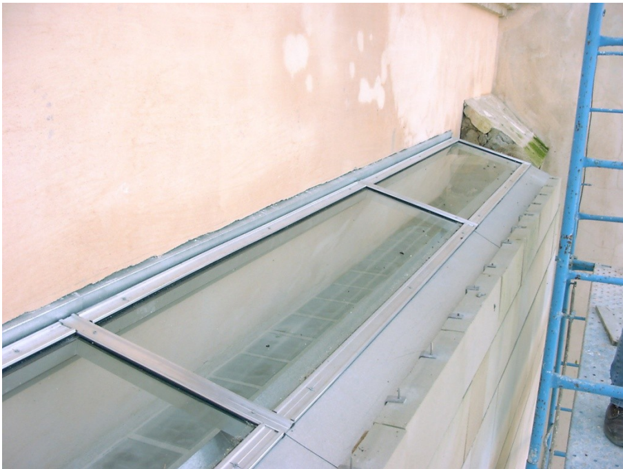
Figura 344 Detalle del sistema lucernario en los nuevos muros de cerramiento. Se observan los dos niveles de acristalamiento, el primero de vidrio moldeado, cámara de aire ventilada y plano acristalado exterior con perfilera de aluminio. Foto del autor.
