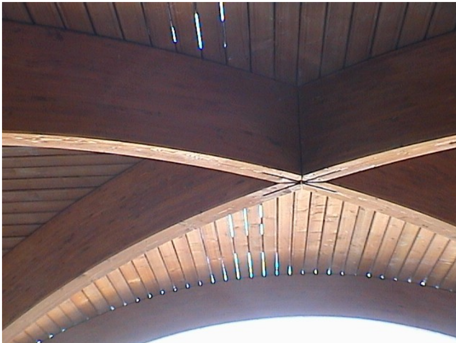
Figura 340 Efecto de cierta transparencia en las bóvedas al iluminarse el espacio entre ellas y las cubiertas. Foto del autor.
