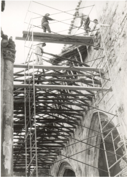
Figura 264 Estructura de cubierta nave Evangelio. Foto de 1969
