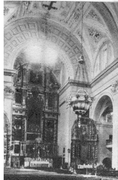
Figura 193 Iglesia en su estado original http://www.funjdiaz.net/basefotos/alta/va1496.jpg
