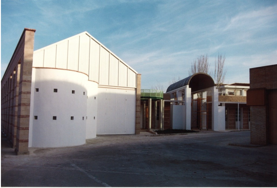
Figura 181 Edificio proyecto, obra y foto del autor
