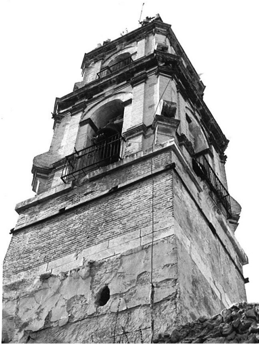
Figura 268 Torre arriostrada con tirantes metálicos en los cuerpos Foto del autor 1987
