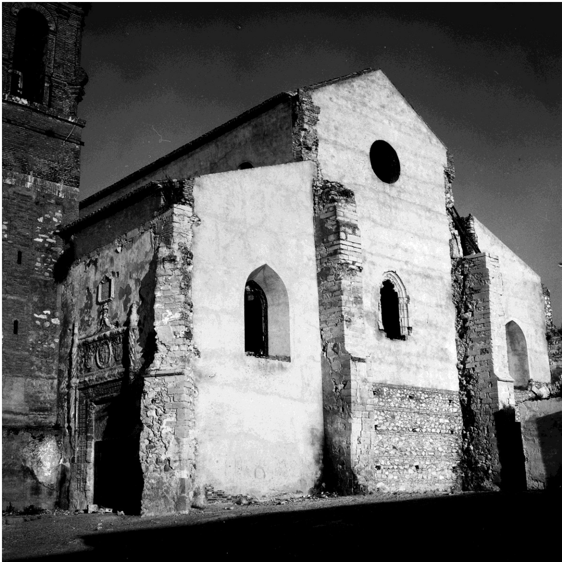
Figura 296 Foto de Carmelo Ruiz se observa el muro de cerramiento reconstruido sin huella del arco de entrada al antiguo coro.
