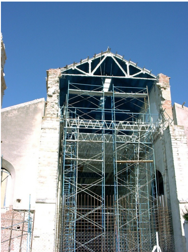
Figura 348 Situación de partida, cubierta existente. Foto del autor.
