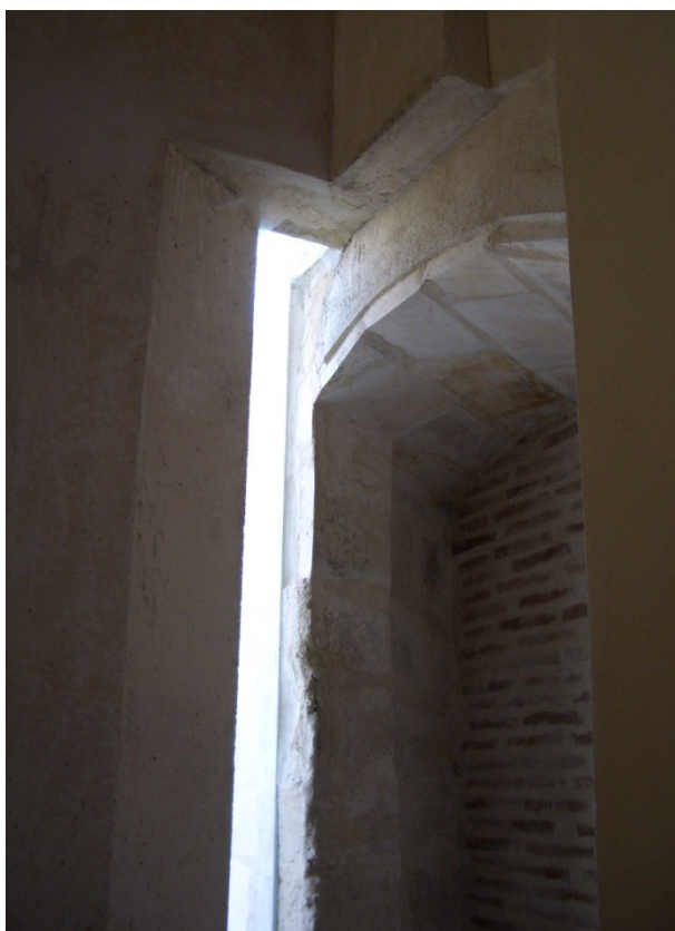
Figura 312 Foto del autor .Encuentro nuevo muro con el contrafuerte.
