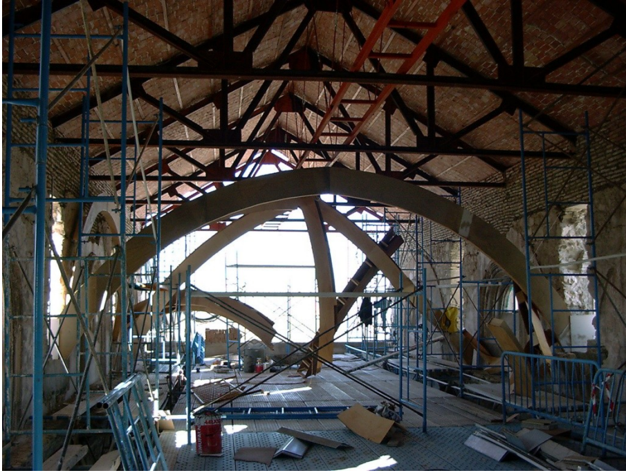
Figura 357 Construcción de modelos de arcos a escala real. Foto del autor.
