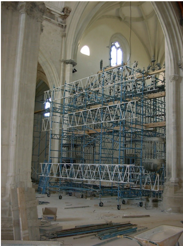
Figura 364 Dispositivo para el traslado de la reja del presbiterio. Foto del autor.
