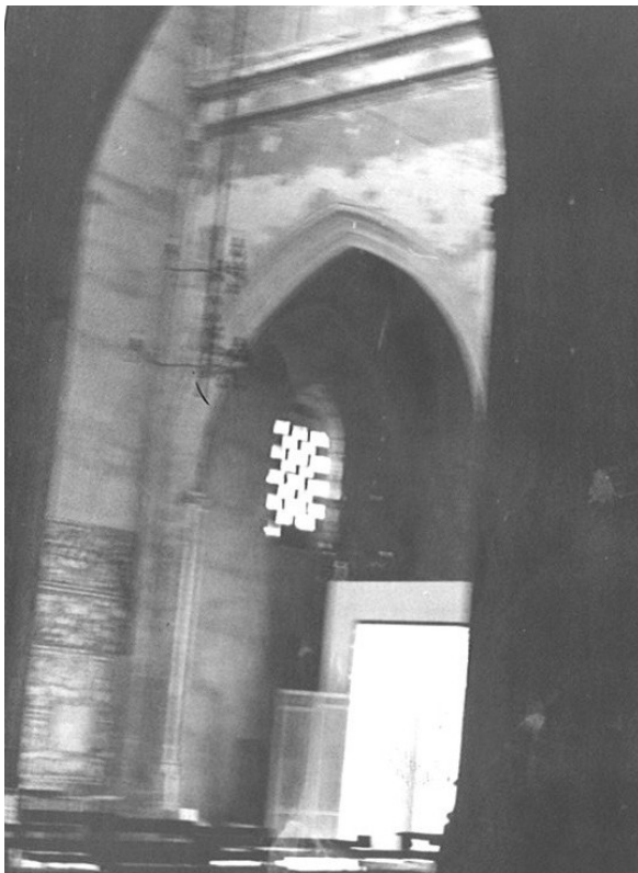
Figura 301 Muro de cerramiento del coro reconstruido sin huella del arco de acceso que tuvo. Foto del autor en 1987
