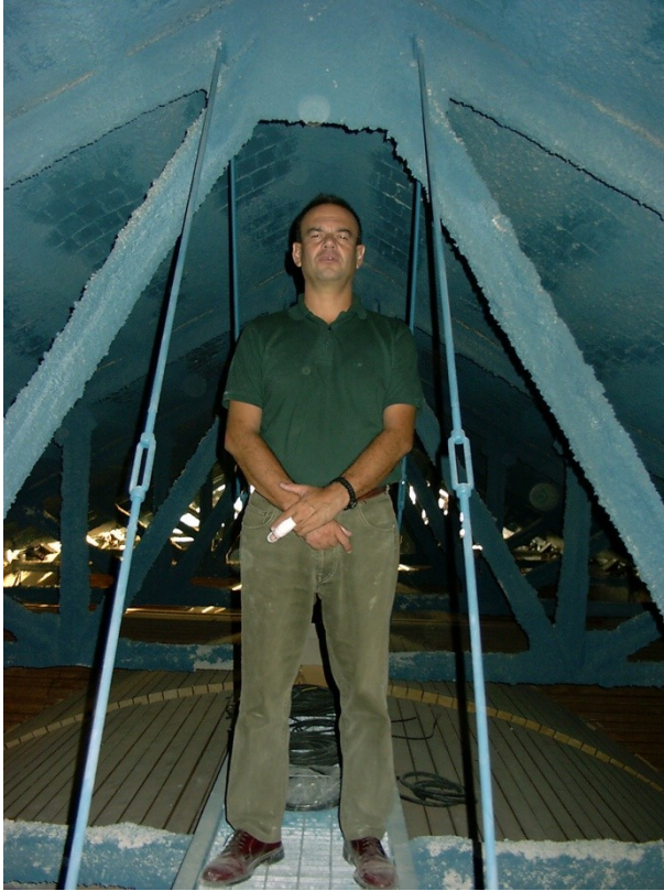
Figura 343 Foto del autor, en la pasarela interior de mantenimiento para las bóvedas de madera laminada.
