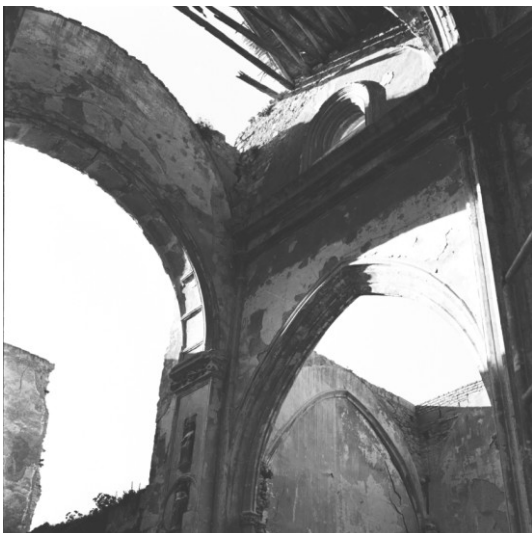
Figura 263 Sistemas constructivos de muros y cubierta restos tras el incendio Foto del arquitecto J. Antonio Gómez Luengo 1972
