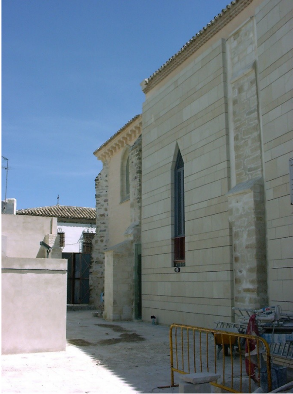
Figura 319 Nuevos cerramientos en Fachada Norte, nave del Evangelio. Foto del autor.
