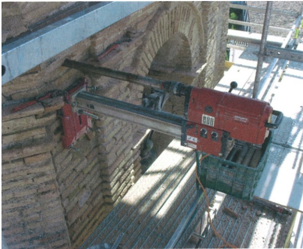
Figura 347 Detalle de la perforadora Consolidación de la Torre mediante el sistema de cosido estático. Foto del autor.
