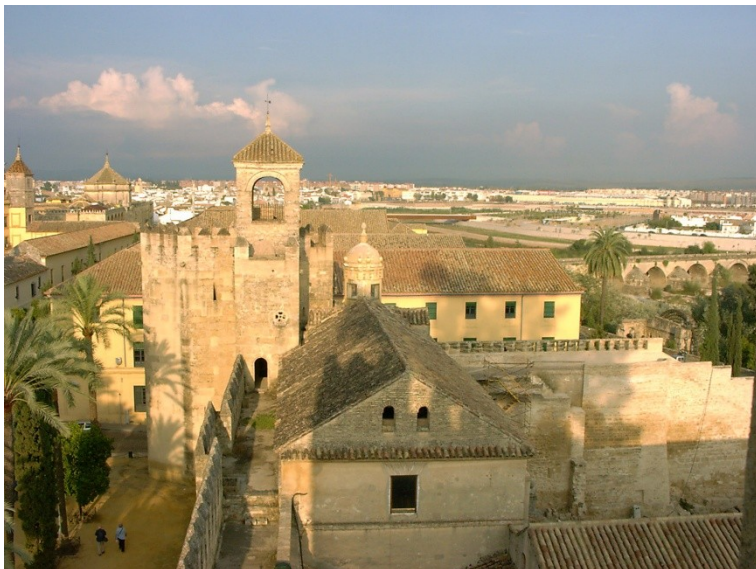
Figura 160 Restauración de las fábricas de cantería en lienzos murales, torres y adarves. Alcázar de los Reyes Cristianos de Córdoba. Foto del autor
