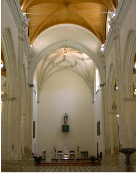
Figura 125 Iglesia Sª Mª la Mayor Baena Córdoba estado tras la Restauración para la recuperación del culto proyecto, obra y fotografía del autor
