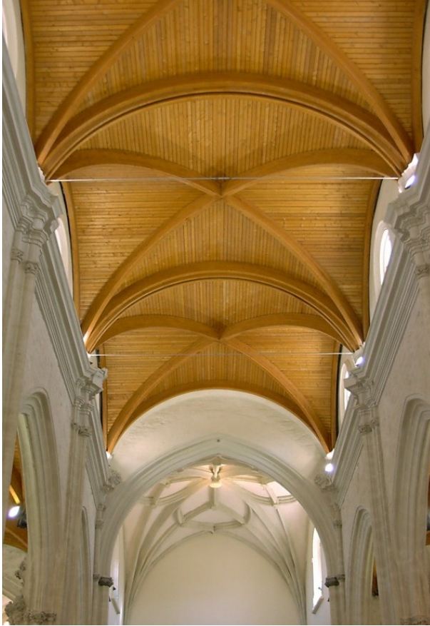
Figura 318 Bóvedas de la nave central. Foto del autor
