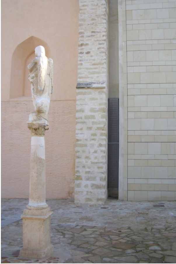
Figura 362 Nuevo cerramiento del coro en la fachada Oeste. Cantería ventilada junto al contrafuerte restaurado. Foto del autor.
