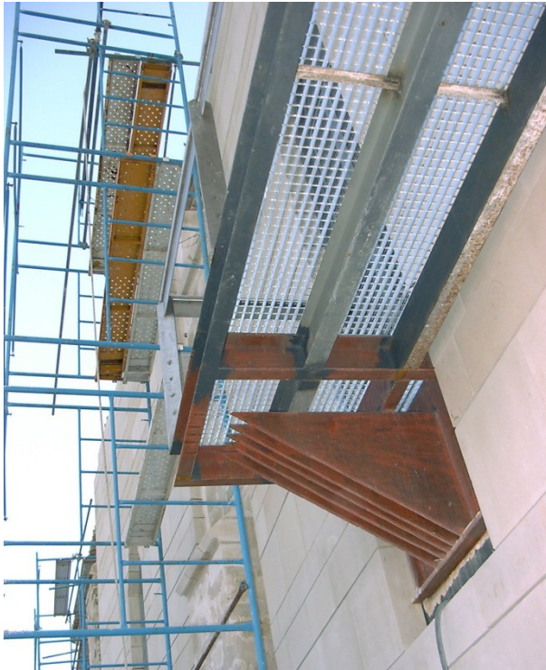
Figura 326 Materiales utilizados en SMLM rejilla electro-fundida en pasarela de acceso a Torre. Foto del autor.
