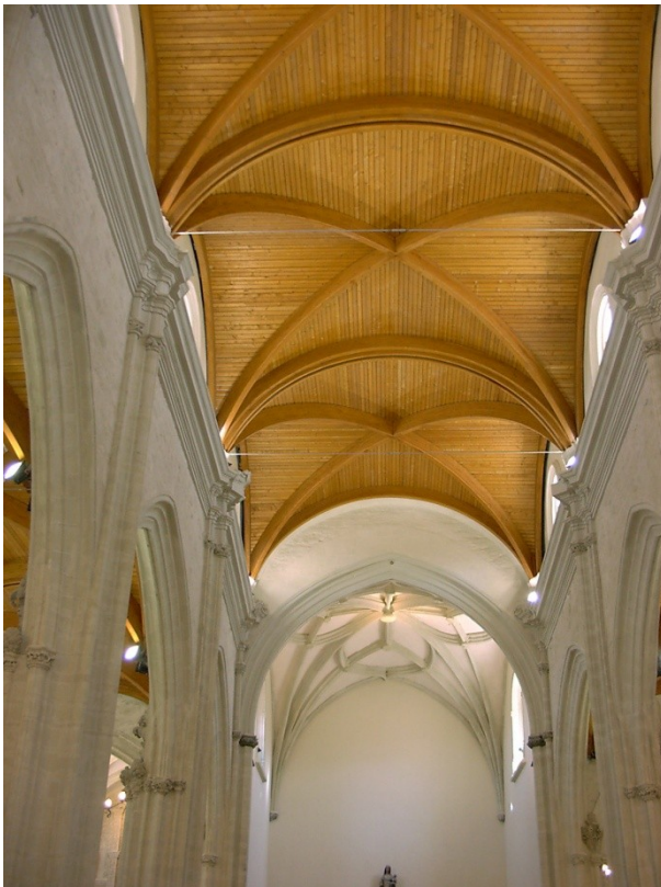
Figura 295 SMLM bóveda de madera laminada en nave central. Foto del autor
