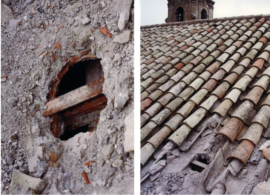
Figura 290 Foto del autor cubiertas y cata en faldon
