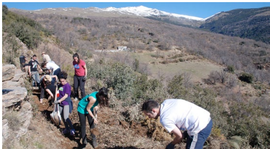
Recuperación de acequia
