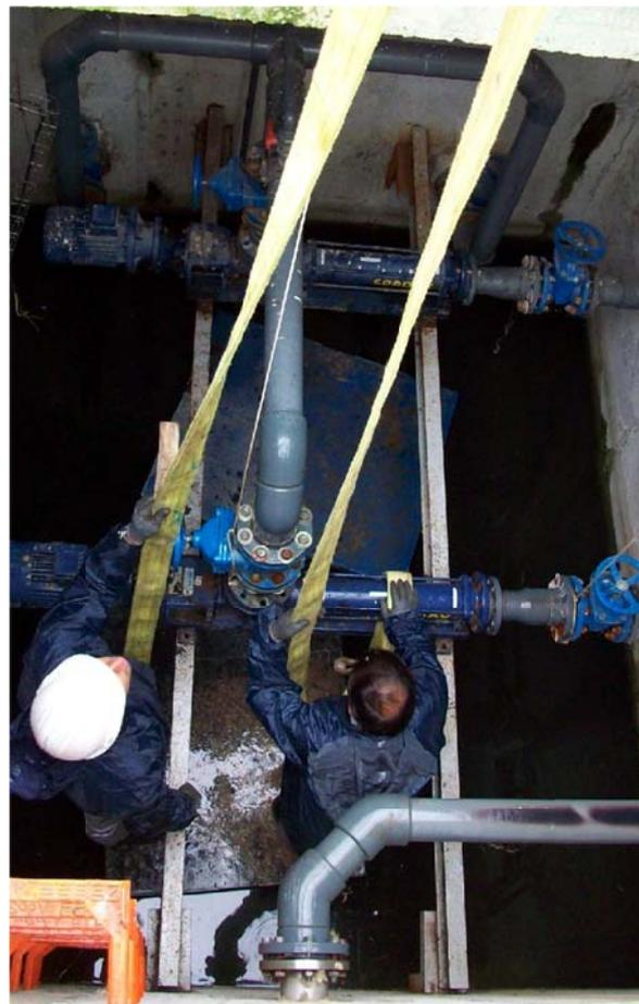
*Figura 40: Sujeción de una bomba de recirculación de fangos en una EDAR.*
