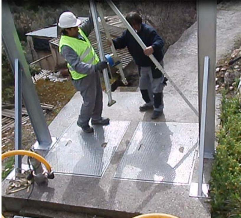
*Figura 86: Adecuación del trípode a la superficie de acceso*
