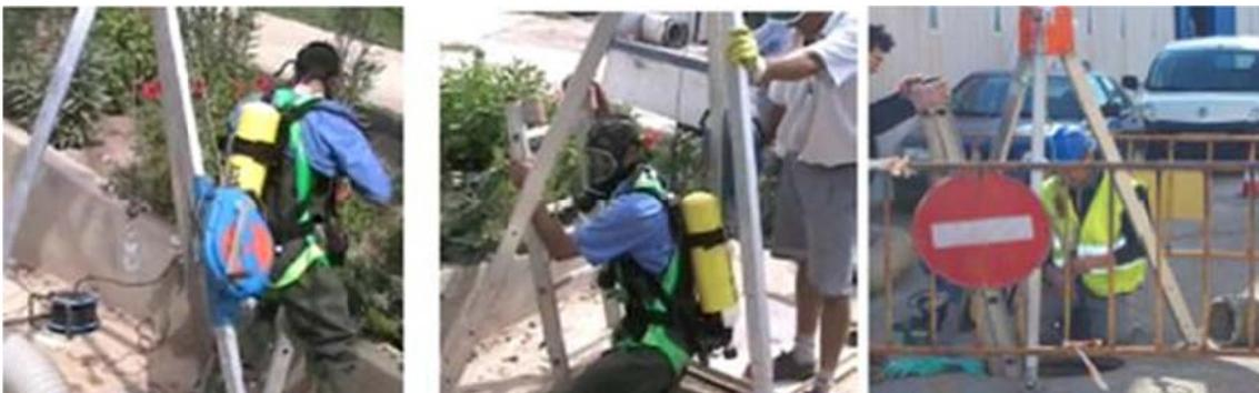
*Figura: 7: Bajadas a EECC mediante escalera manual*
