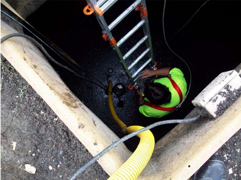
*Figura 91: Sacando aireador averiado sin ERA, ni medidor de gases*
