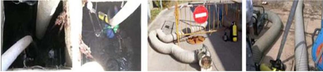
*Figura 3: Operación de ventilación de arquetas*
