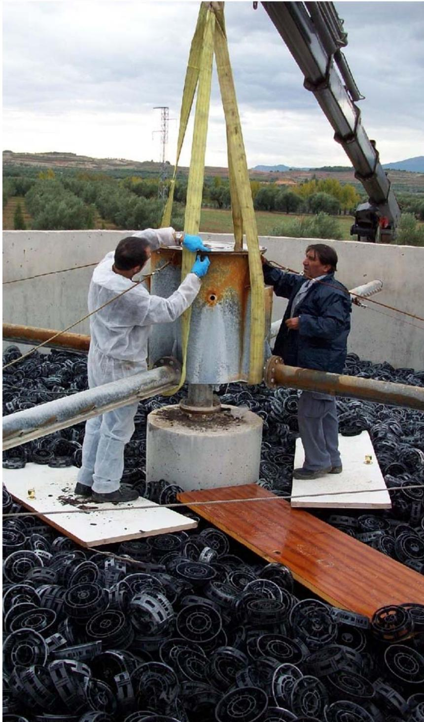
*Figura 38: Sujeción del distribuidor del lecho bacteriano de una EDAR.*
