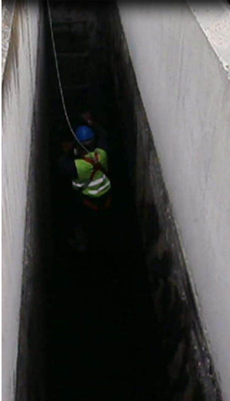
*Figura 82: Acceso al espacio confinado con pates fijos instalados en pared*
