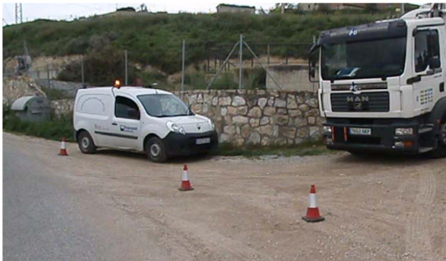
*Figura 77: Balizamiento y señalización de la zona de trabajo en la EDAR de Orce*
