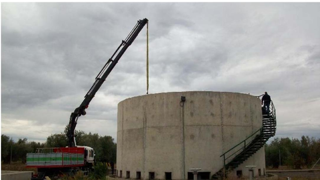
*Figura 37: Colocando el distribuidor del lecho bacteriano de una EDAR.*
