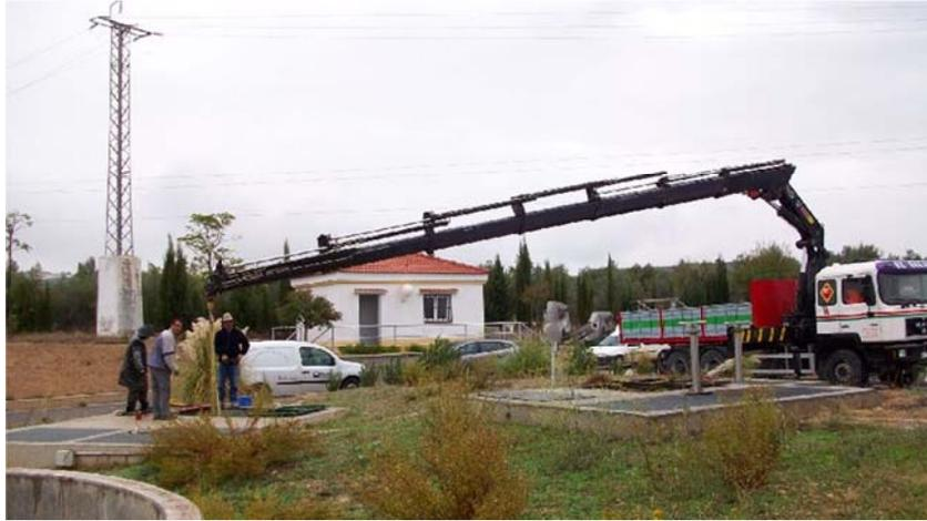
*Figura 39: Sacar bomba de recirculación de fangos en una EDAR.*
