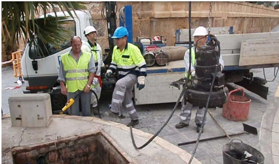
*Figura 41: Sacar bomba de aguas residuales en una EBAR.*
