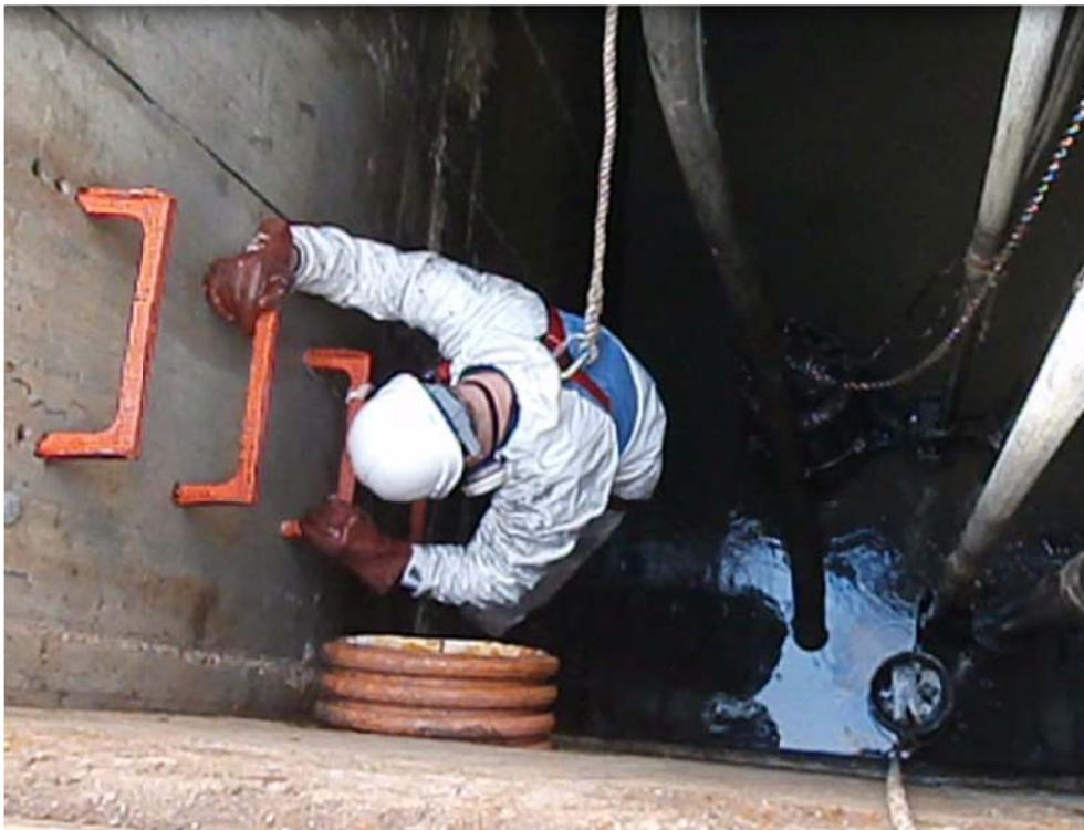
*Figura 81: Acceso al espacio confinado mediante pates fijos instalados en la pared*
