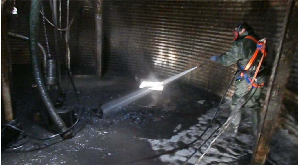
*Figura 92: Limpieza de tanque de salmuera con camión de saneamiento*
