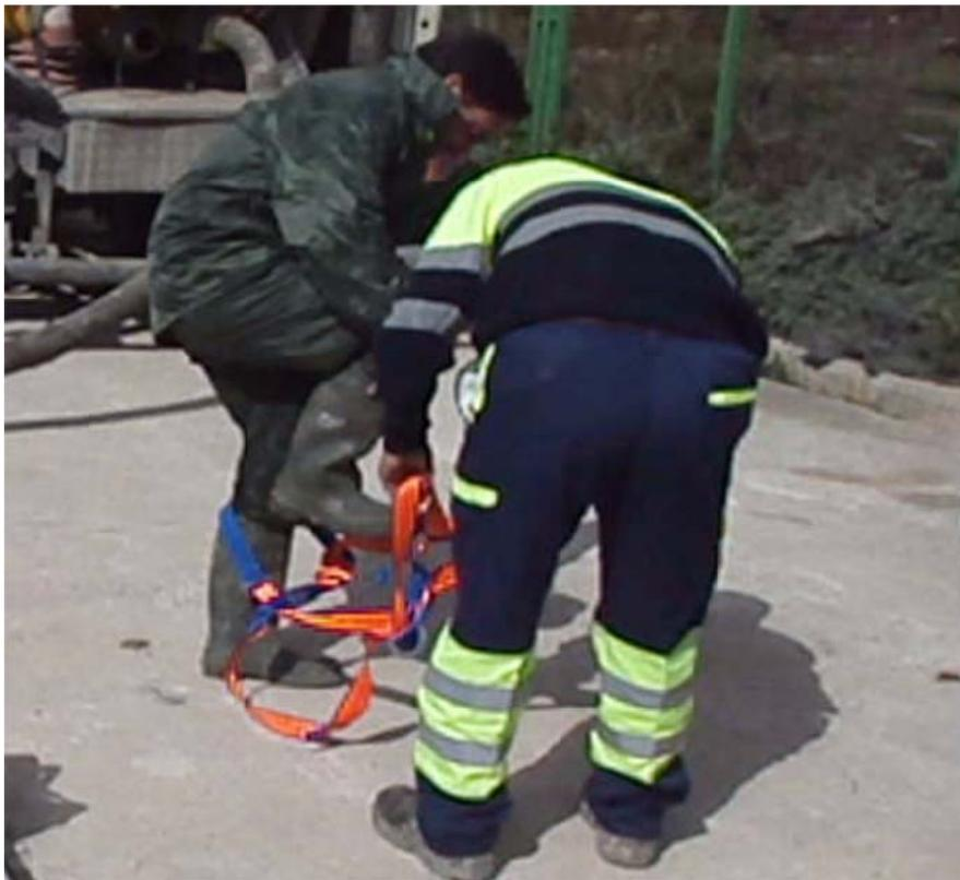
*Figura 71: Preparación de trabajador para acceder a un EC*
