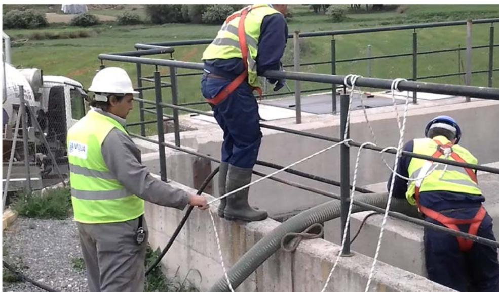
*Figura 61: Operario sujeto a la cuerda de vida sin posibilidad de colocar trípode*
