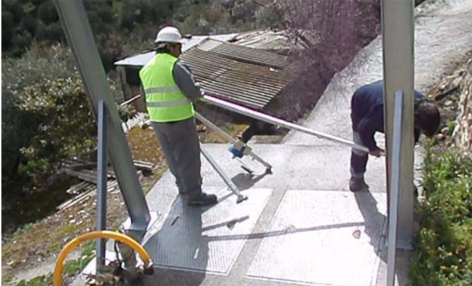
*Figura 85: Adaptación del trípode a la altura deseada*
