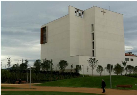
Figura 13 Las fachadas de la iglesia de Riberas de Loiola, en Donostia-San Sebastián-, están revestidas con mortero auto-limpiante y descontaminante.
