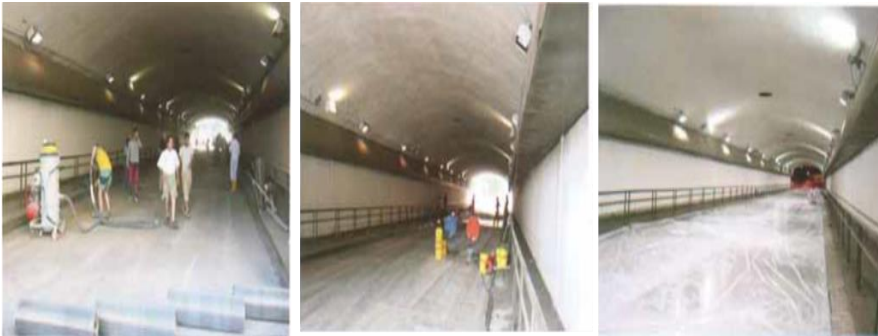
Figura 11 Colocación del pavimento fotocatalítico en el túnel de Via Pórpura (Milán).
