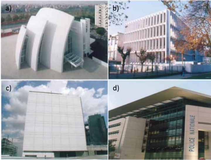
Figura 12 Edificaciones de prestigio realizadas con cemento fotocatalítico. a) Iglesia Dives in Misericordia (Roma), b) Edificio de la Ciudad de la Música y las Bellas Artes (Chámbery) c) Sede de Air France (Aeropuerto Roissy Charles de Gaulle) y d) Sede de la Policía (Burdeos).
