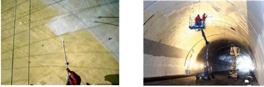
Figura 6 Operaciones de pintado con pintura fotocatalítica del túnel Umberto I en Roma (Italia).
