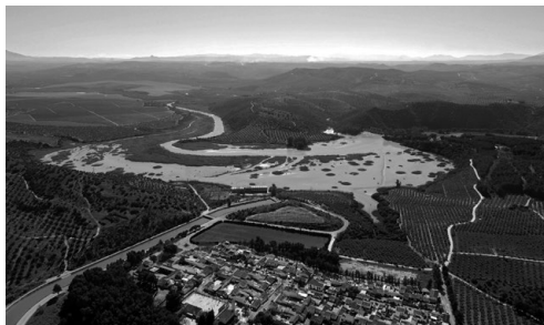
Figura 10: estado actual del paraje natural «Embalse de Cordobilla», prácticamente colmatado por una actividad erosiva de gran intensidad. Fuente: Juan de la Cruz Merino.
