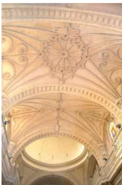
Fig. 7. Sistema de bóvedas del Oratorio de S. Felipe Neri. Granada. Melchor de Aguirre. 1685-1717. Foto: (J.A.D.G.)
