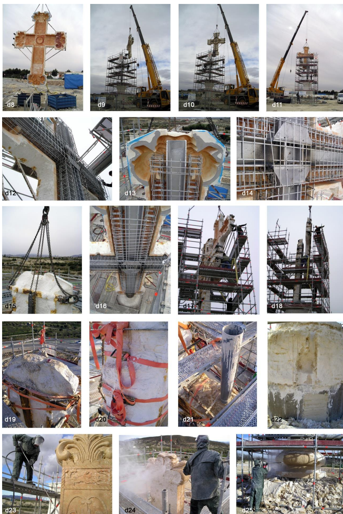
Fig. 5: Composición I del proceso técnico-constructivo en glorieta MU-414, Juan Fco. Martínez Gómez de Albacete, 2015. Abanilla (Murcia). Foto: JFMGA.
