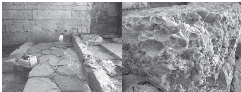
Lám. 11: a) Reutilización de piedras conglomeráticas violáceas en la sala de molienda del Molino de Martos. b) Detalle de una de estas piedras conglomeráticas (Foto: M. Altamirano).
