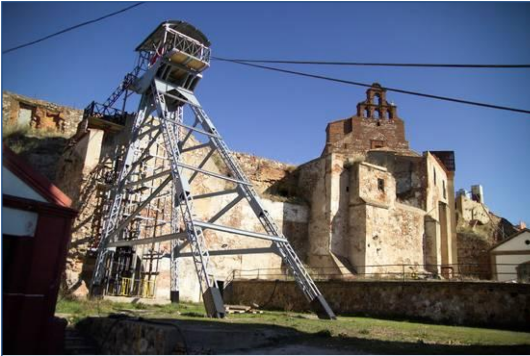
Figura 70. Fotografía Castillete del Pozo de San Aquilino. Fuente: https://www.tripadvisor.es 06/12/2016
