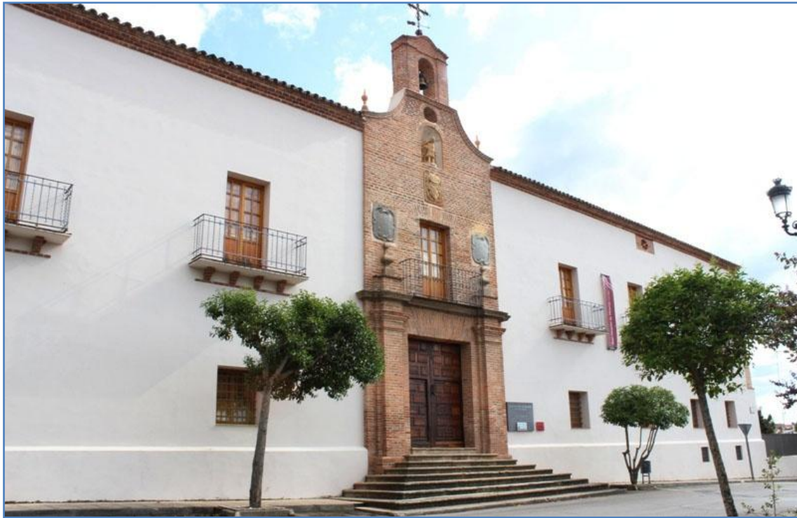
Figura 143. Fachada ladrillo encalado Hospital de los Mineros de Almadén. Fuente: http://www.viajeuniversal.com Consultado 05/02/2016
