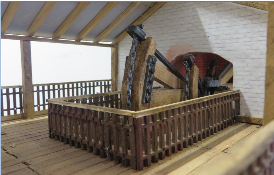
Figura 190. Detalle balancín de la maqueta de la primera máquina de vapor de minas de Almadén. Fuente: (Molina de las Heras & Calderón Herrera, 2016)
