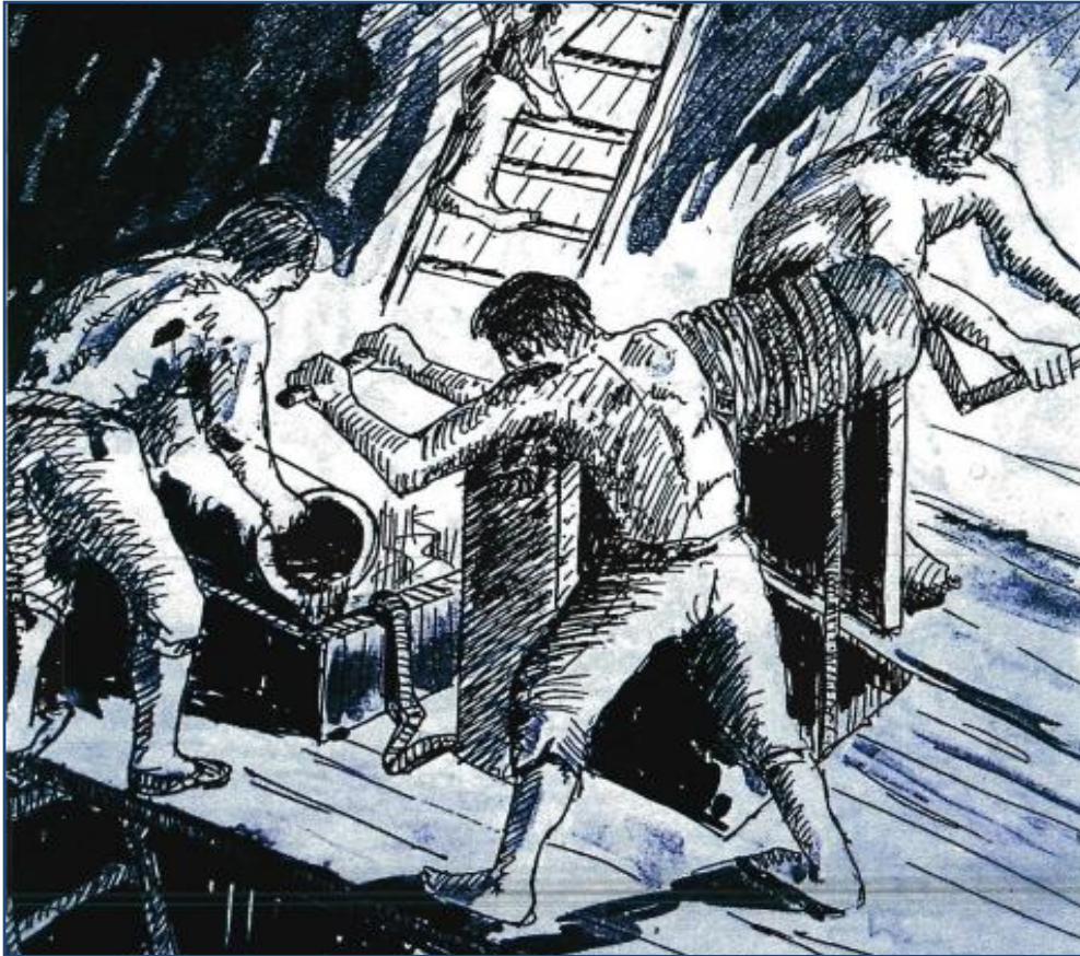
Figura 81. Desagüe a fuerza de sangre con torno de mano y zacas de cuero. Fuente: (Hernández Sobrino & Fernández, 2005)
