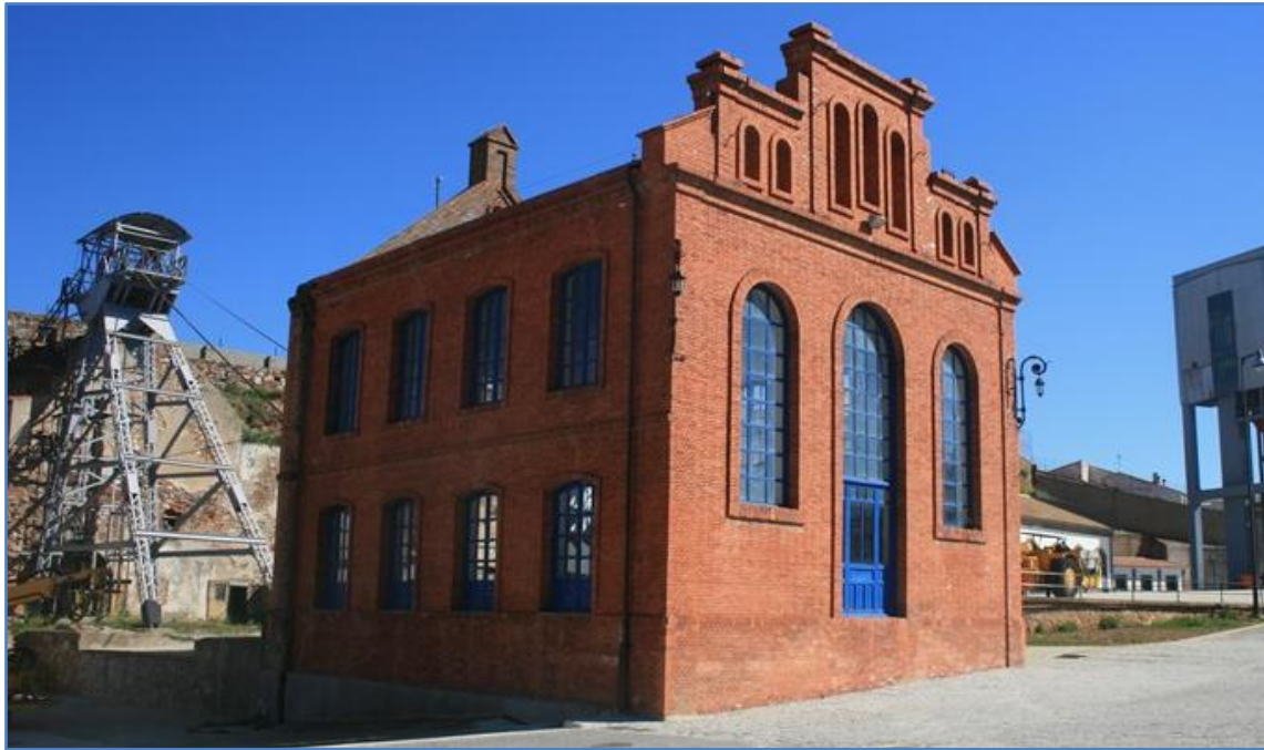
Figura 141. Sala de máquinas del pozo de San Aquilino de minas de Almadén. Fuente: http://www.mayasa.es Consultado 05/02/2016
