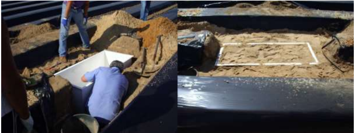
Figura 8. Instalación de los lisímetros de drenaje
