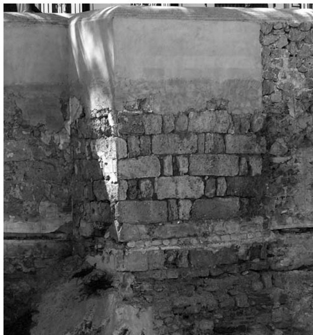
LÁMINA 7. Torre de flanqueo califal del frente norte de la madina de Ceuta.
