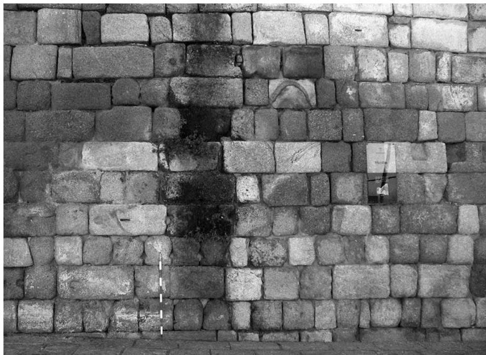
LÁMINA 1. Detalle de las murallas de Coria (Cáceres), donde destaca la construcción con material de acarreo de origen clásico.
