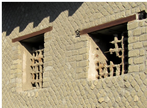
Fig. 3: Cerramientos de vanos exteriores con rejas metálicas, Herculano (Fuente: A. Velo Gala).
