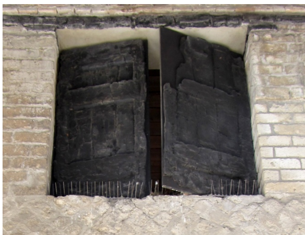
Fig. 2: Postigos de madera de un vano del segundo piso de una vivienda en Herculano (Fuente: A. Velo Gala).
