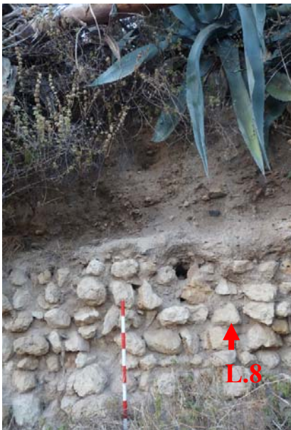
Fig.18 L.8: tabiya sobre zócalo de mampostería.
