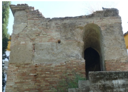
Fig.35 Izda: Adarve y acceso a interior T.II. Centro: Vano de acceso a cámara T.IX. Dcha: Bóveda vaída de ladrillo de T.IX.
