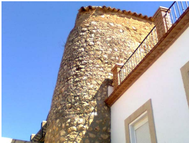
Fig.11 Torre T.I o «Redonda». Parte superior.
