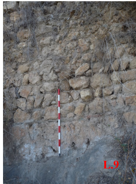
Fig.19 L.9: Disposición de mampuestos en «espina de pez».
