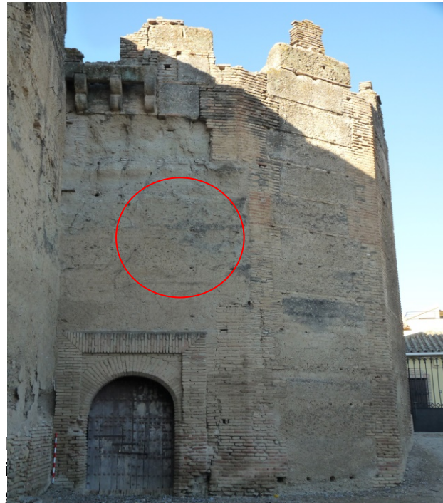
Fig.43 T.I. Actual capilla de las Angustias. Área marcada con tapias de distinto módulo al resto de caras.
