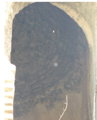
Fig.35 Izda: Adarve y acceso a interior T.II. Centro: Vano de acceso a cámara T.IX. Dcha: Bóveda vaída de ladrillo de T.IX.
