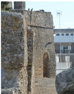
Fig.35 Izda: Adarve y acceso a interior T.II. Centro: Vano de acceso a cámara T.IX. Dcha: Bóveda vaída de ladrillo de T.IX.
