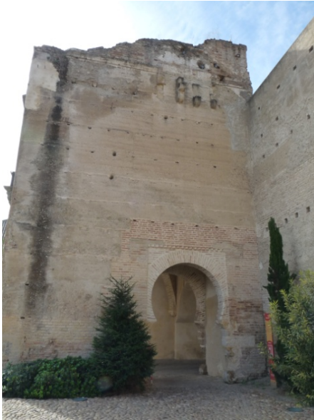
Fig.44 Puerta Este. T.VII. Dcha.: Doble arco rehundido en el alfiz.
