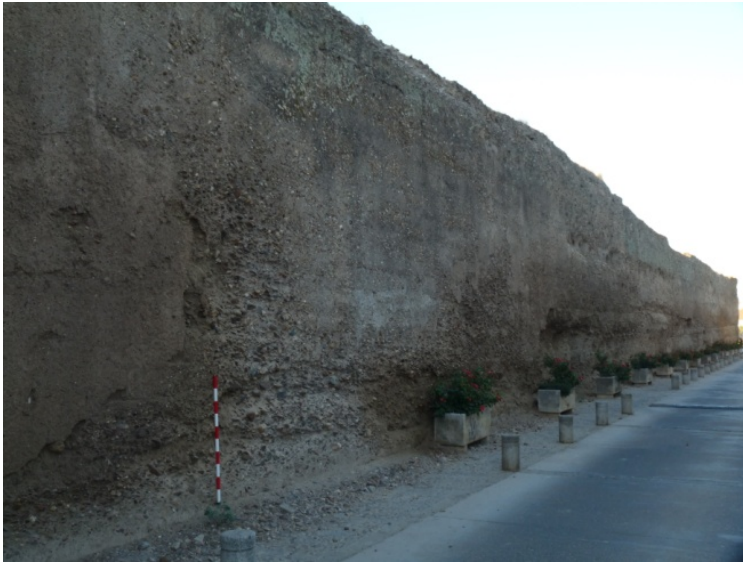
Fig.37. L.1. No existe verdugado, remate latericio ni merlatura.
