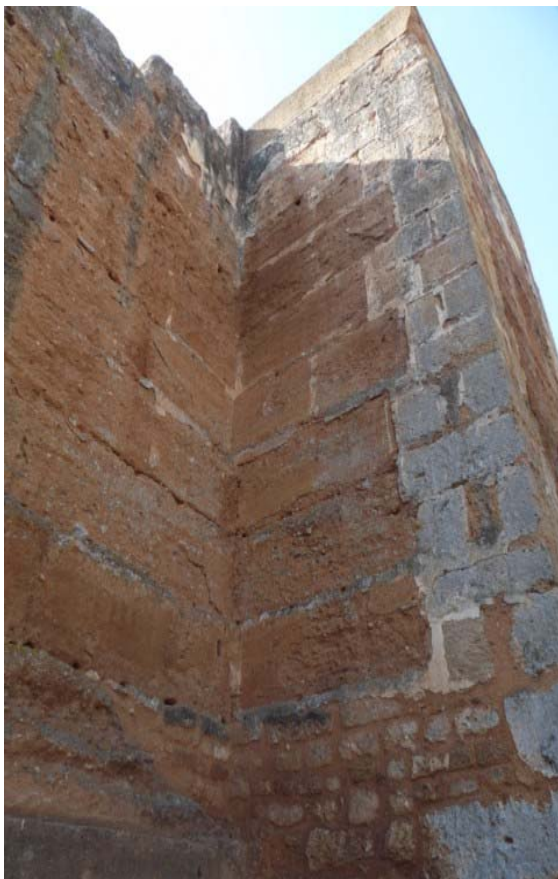
Fig.4 Falso despiece de sillería. Flanco N.W. Muralla de Niebla.
