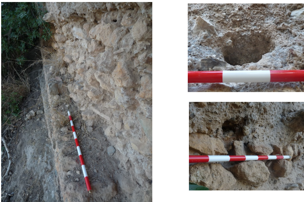
Fig.20 L.10. Izda.: Zócalo de mampostería sobre la roca. Dcha.: Detalle hueco agujas (sup.) y tapia sobre mampuesto (inf.).
