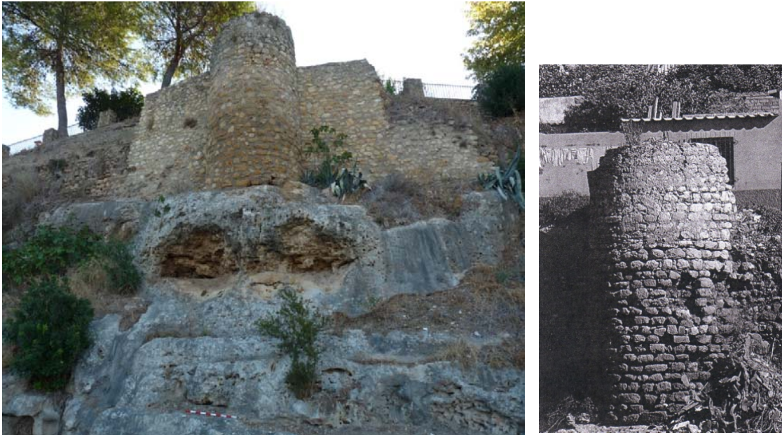
Fig.12 T.II. Izda.: Estado actual. Dcha: previo a restauración (Dcha.: Ortiz, 1986: 279).
