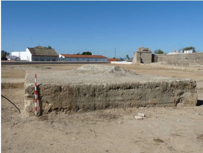
Fig.49 Alcazaba: T.XV. Obsérvense sillares en esquinas.
