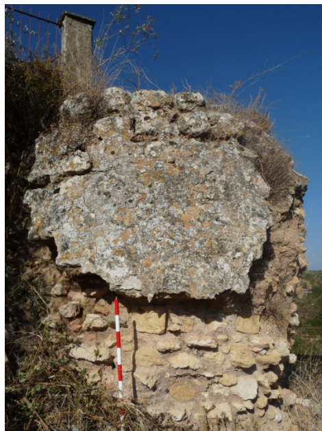
Fig.15 T.IV. Sup.: Vista gral. Inf.: Detalle del forro de sillarejos.
