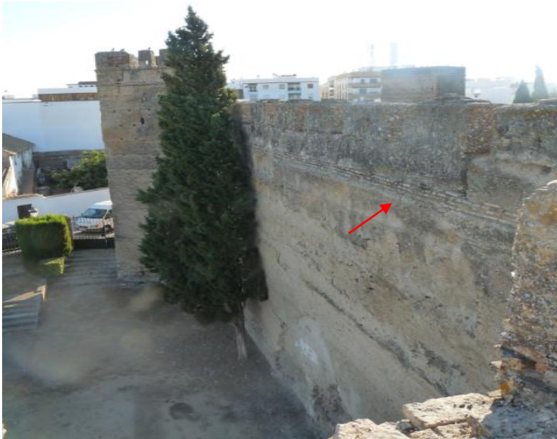
Fig.39 L.2 y T.II. Verdugadas de ladrillo.
