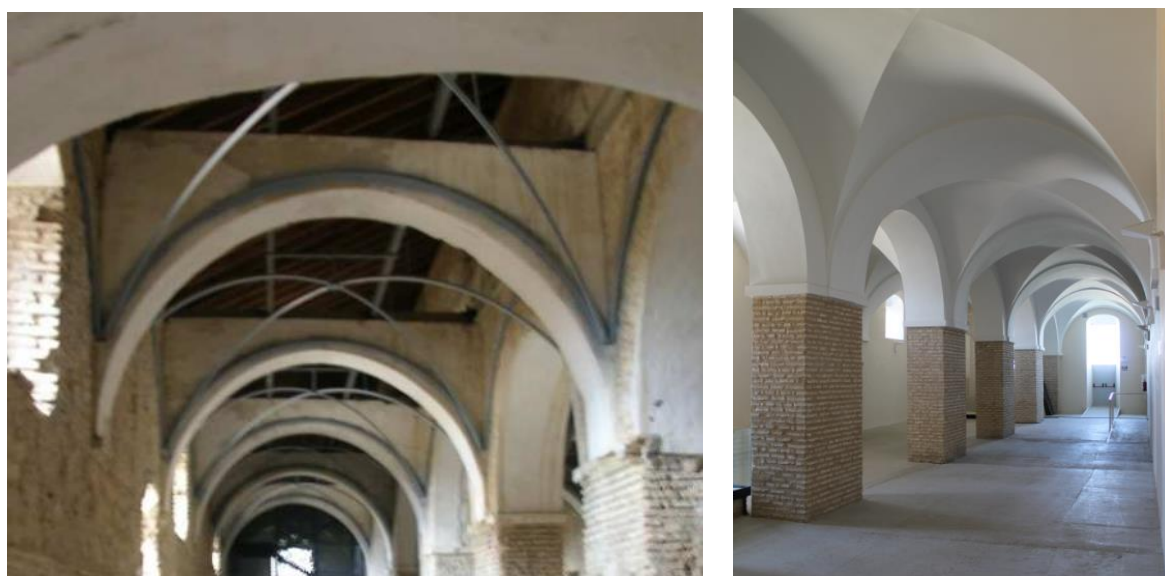
Ilustración 91. Interior del alhorí de Montilla. Nave lateral. Planta baja. A la izquierda detalle de las cerchas para la instalación de la bóveda de crucería 200
