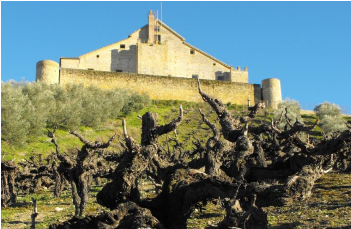
Ilustración 74. Fachada occidental del Alhorí 177
