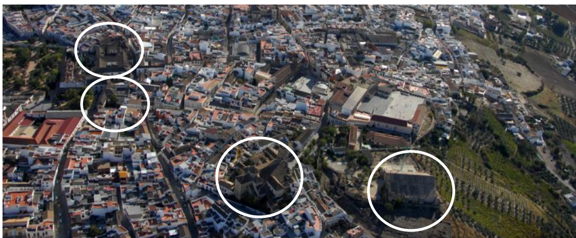
Ilustración 45. Vista aérea de Montilla. De izquierda a derecha, destacados con un círculo: Convento de Santa Clara, Palacio de los Duques de Medinaceli, Parroquia de Santiago Apóstol y Alhorí de los Duques de Medinaceli
