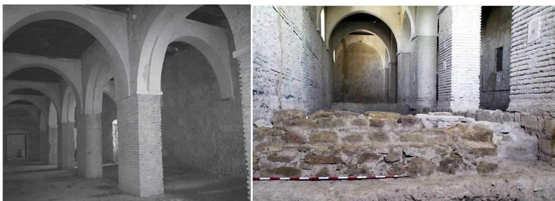
Ilustración 90. Nave lateral del Alhorí antes de la restauración (izq.) y durante la excavación del mismo en junio del año 2000 (drcha) 199
