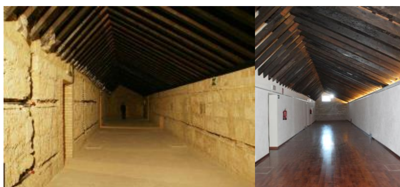
Ilustración 93. Nave lateral de la planta alta 202
