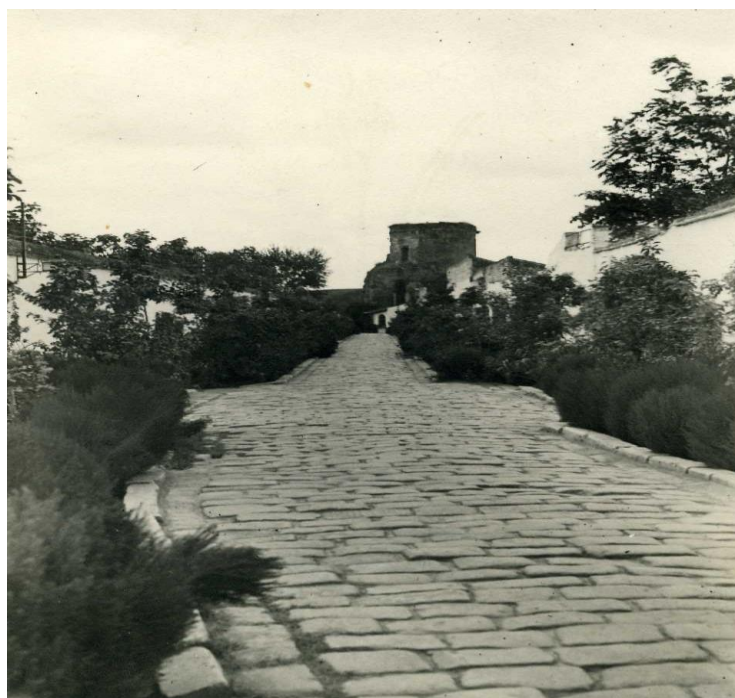
Imagen 86.- Depósito de Sementales de Córdoba. Pasillo Huerta, 1940 630 .
