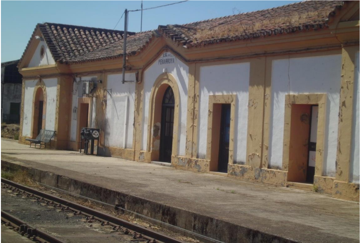
Imagen 80.- Estación de Peñarroya. Línea ancho nacional de Belmez-Almorchón. Foto actual. Foto propia.
