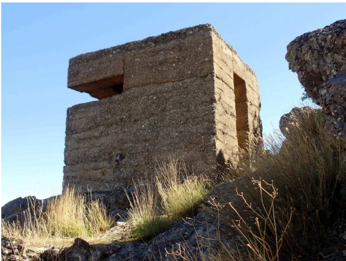
Imagen 53.- Bunker construido de hormigón armado. Foto: Pepe Lozano.
