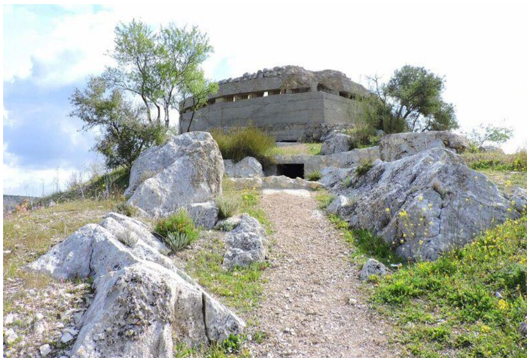
Imagen 44. -Bunker y Centro de Mando del Cerro del Alamillo en Luque. Foto: Pepe Lozano.
