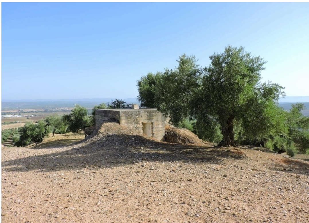
Imagen 51.- Bunker del cortijo del francés. Foto: Pepe Lozano.
