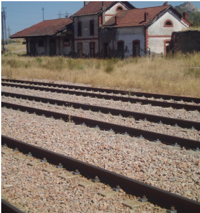
Imagen 79. -Restos de la Estación de la línea Métrica en Peñarroya, Fuente del Arco- Peñarroya- Puertollano-San Quintín, de la empresa SMMP. Foto actual. Foto propia.
