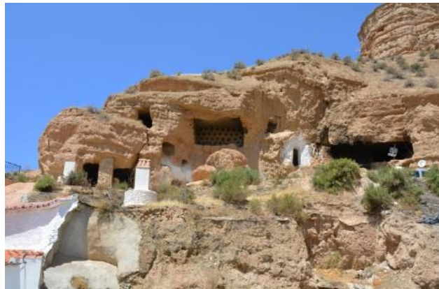
Imagen 22. Grupo oeste del Marchal. La primera cueva por la izquierda es la entrada a la capilla, hoy apuntalada con un pilar. En el centro y derecha de la imagen, los dos columbarios, ennegrecidos por un posible incendio. Se observa la ruina del conjunto, que muestra que pudo tener hasta tres estancias rupestres más, una de ellas también con nichos-columbario.
