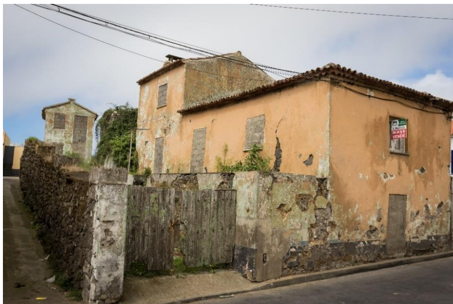
Fig. 8. Casa na Rua dos Afonsos com janela e porta na fachada. Apresenta o polim ao fundo de pedra. Repare-se na antiga falsa que evoluiu para um novo compartimento sobre a cozinha. Foto: Cláudio Pacheco, 2018.
