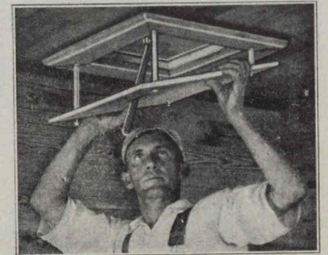
La colocación de este aparato es una operación sencilla. Su instalación permite establecer una aireación normal en relación al volumen de aire respirable, su temperatura, capacidad eliminatoria, etc.
