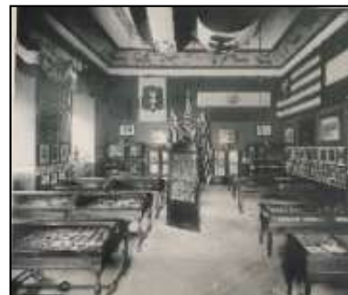
Fig. 80. Detalle de la instalación de Paraguay
