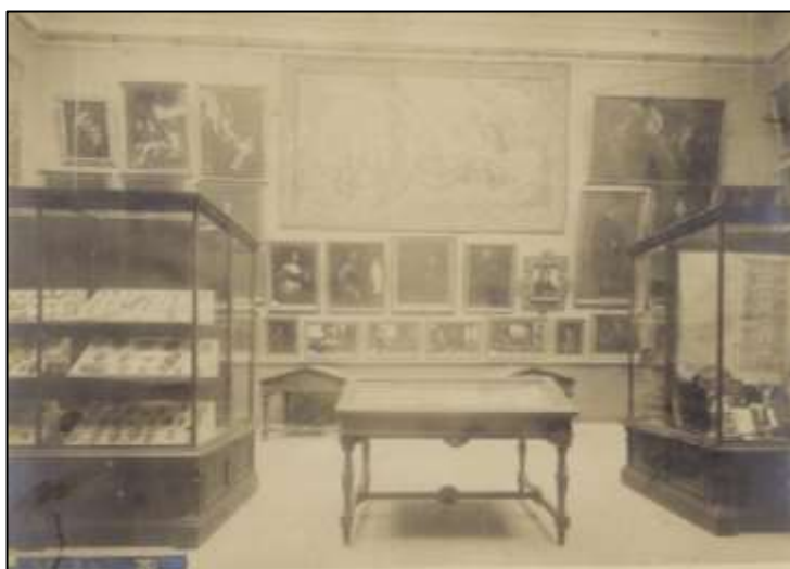
Fig. 148. Sala 20. Otra vista de la instalación. En las paredes se observan retratos y pinturas, y otros en miniatura en las vitrinas, junto a medallas histórico-artísticas, cartas, cédulas, privilegios, y sellos.
