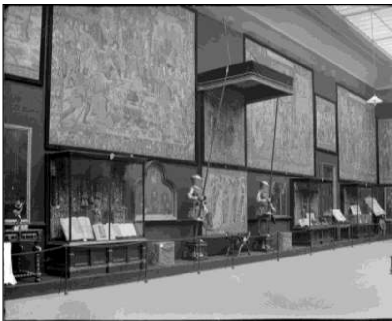
Fig. 122. Vista de parte de la instalación de la Real Casa, Fuente: Instituto del Patrimonio Cultural de España, Fondo Ruiz Vernacci, VN_07948_P
