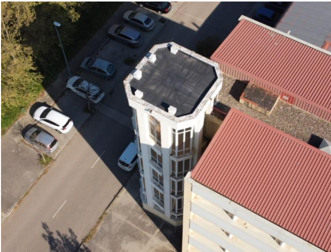
Fig. 25. Cajas nido en la torre del ala oeste del edificio de Sanidad Animal.
