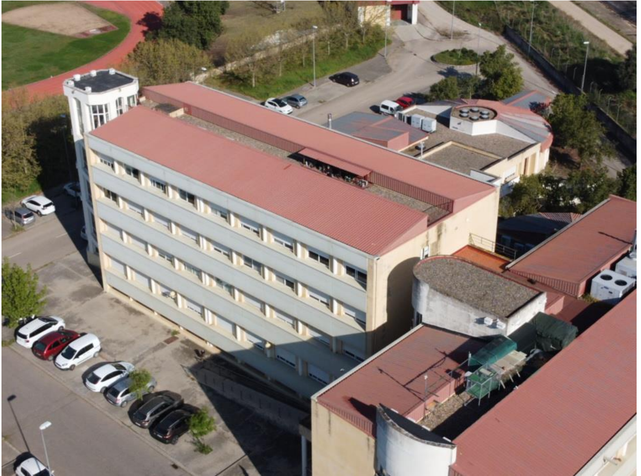
Fig. 8. Ubicación del hacking (edificio de Sanidad Animal) y de nidales adicionales en la torre
