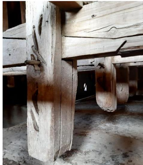
*Imagen 5. Fotografía de una de las péndolas de la estructura. Fuente: propia.*
