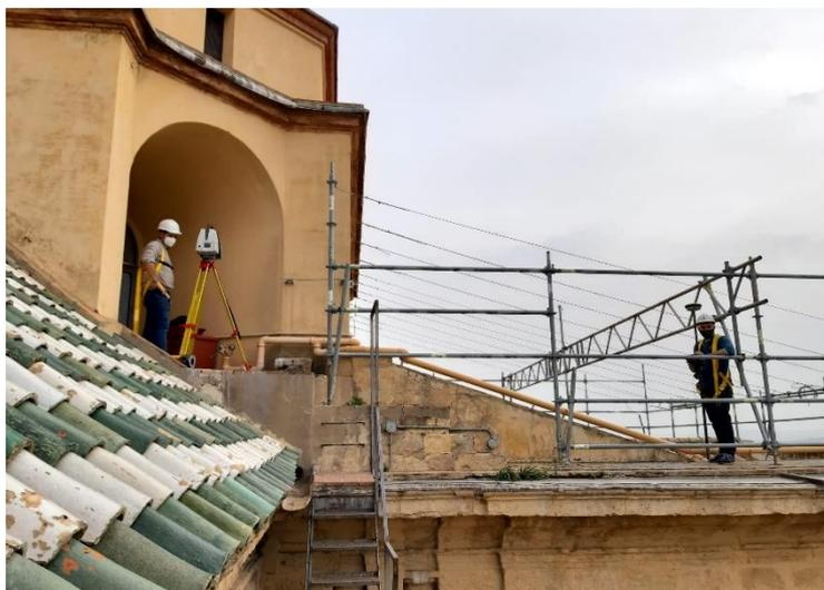
*Imagen 20. Fotografía del momento de la toma de puntos de control con receptor GNSS para la georreferenciación de la nube de puntos. Fuente: propia.*
