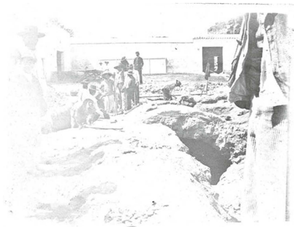
Fig. 353: descubrimiento de las bóvedas de los Baños del Campo de los Mártires durante las excavaciones de 1903. RAH, CACO/9/7952/68.
