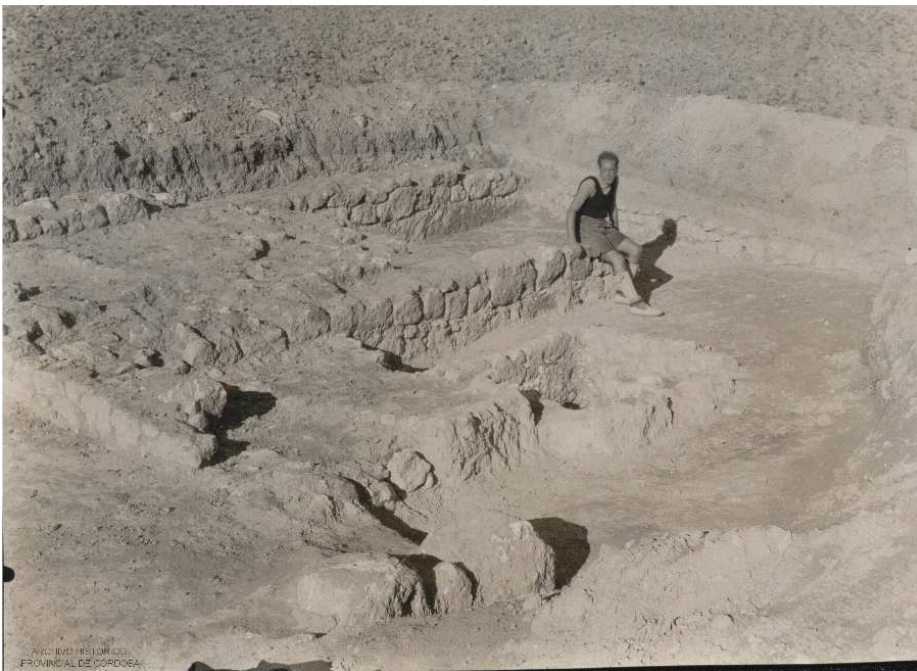
Fig. 265: Julio Martínez-Santa-Olalla junto a una de las viviendas excavadas. AHPC, FRT.
