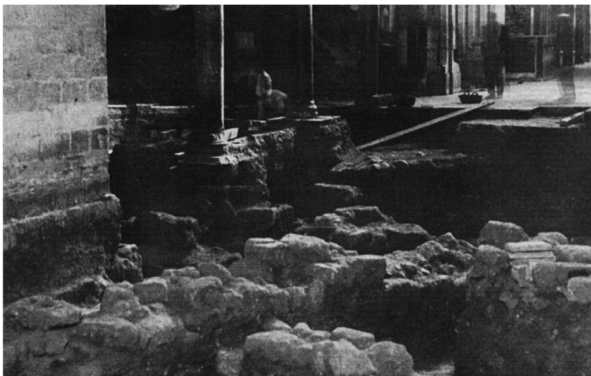
Figs. 326 y 327: excavación en la nave central de la ampliación de Abd al-Rahman II, y mosaico hallado en la excavación en las naves occidentales de Abd al-Rahman I y dado de hormigón de recalzo de la cimentación de la columna, 1932. Museo Arqueológico de Córdoba, Archivo Félix Hernández, PO-47; Herrero, 2015b: 3 y 5.
