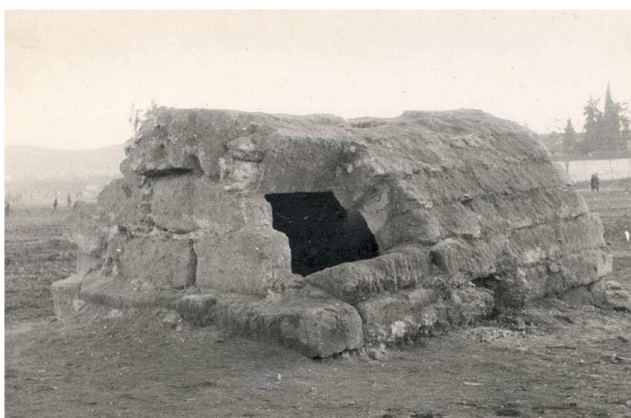
Fig. 284: cisterna de la avenida de Vallellano, fotografiada en el momento de su aparición (al fondo, la tapia del cementerio de N a S a de la Salud). Fotografía de Ladis , s/f. AMC, registro n o FO/A 0088-001/F1-8.
