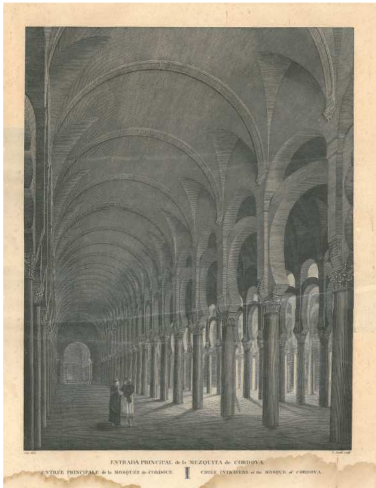
Fig. 313: Entrada principal a la Mezquita de Córdoba , aguafuerte de Thomas Smith para el Voyage pittoresque et historique de l'Espagne de Alexandre de Laborde (vol. 2, plancha 12). El grabado muestra el aspecto del edificio antes del comienzo de las restauraciones, con techumbres embovedadas y arcos enjalbegados. Imagen digitalizada por la Biblioteca Municipal de Córdoba.
