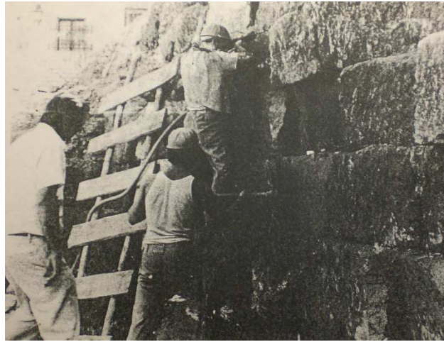
Figs. 389 y 390: cara, y cruz, del Servicio de Arqueología Urbana. Hipogeo conservado en el subsuelo de la Diputación Provincial (Vaquerizo, 2001: 213) y destrucción, con martillo neumático, del muro de una edificación del foro, exhumada en 1974 en la calle Ramírez de Arellano (Marcos y Vicent, 1985: 252).
