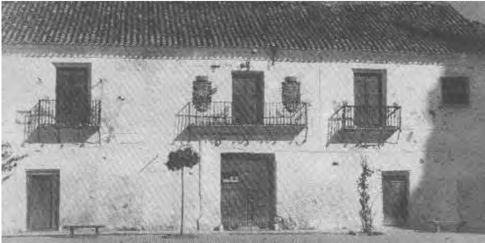
Figura 2: Fachada del desaparecido Palacio de Benamejí. Fuente: https://www.foro-ciudad.com/cordoba/benameji/fotos/52830-palacio-desaparecido-de-los-marqueses-de-benameji.html
