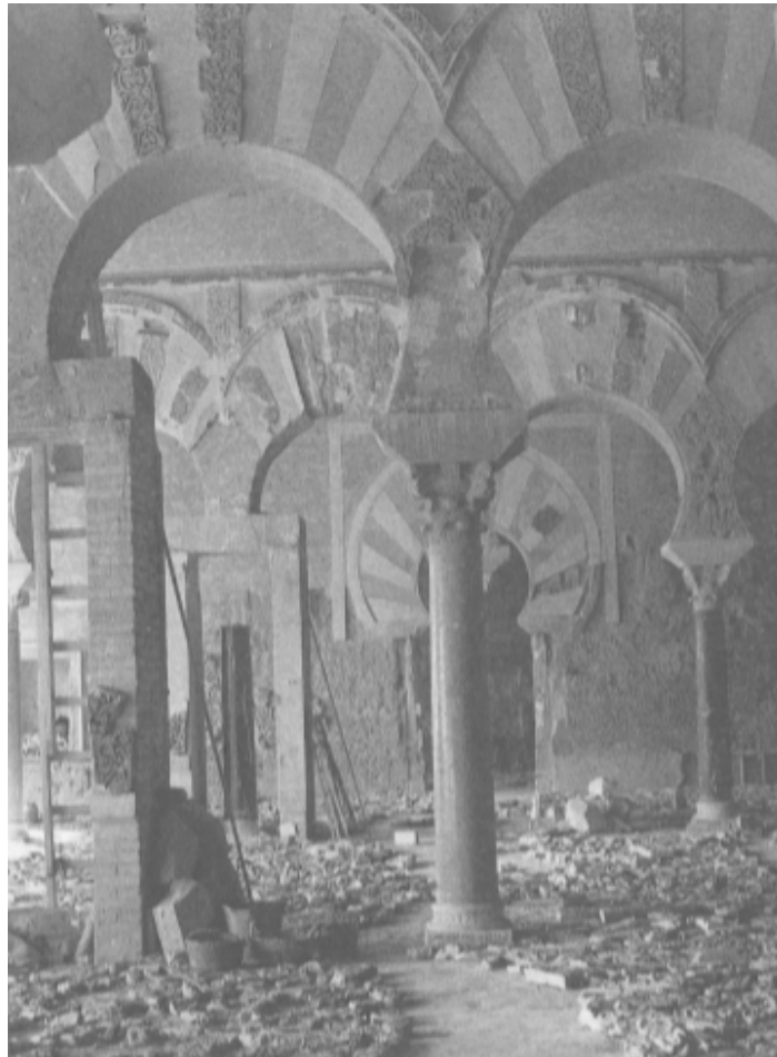
Figura 18. Córdoba. Medina Azahara. Exterior e interior del Salón de Abd al-Rahman III durante su restauración en tiempos de Félix Hernández (Vallejo, 1995: 27).
