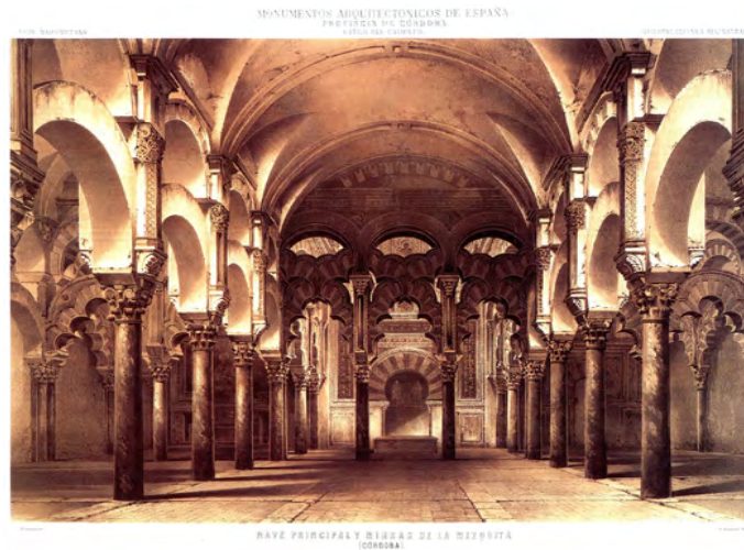
Figura 7. Córdoba. Mezquita-Catedral. Grabado de 1879. Bóvedas encamonadas de la nave axial antes de la restauración de Velázquez Bosco. Fuente: http://otraarquitecturaesposible.blogspot.com/2011/05/la-mezquita-catedral-de-cordoba-para_20.html .
