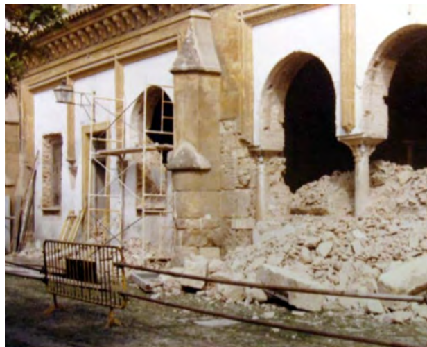
Figura 15. Córdoba. Mezquita-Catedral. Proceso de demolición del cerramiento de la galería norte del patio. 1982 (Herrero, 2015a: 227).
