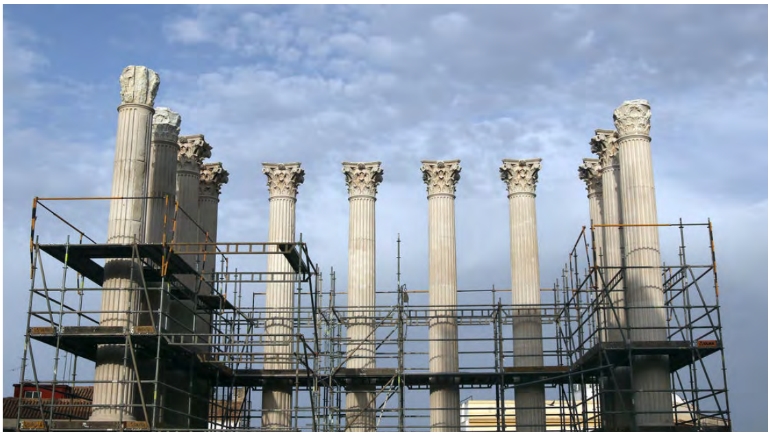
Figura 40. Córdoba. Templo Romano. Detalle de las columnas durante la restauración acometida en 2017. Obsérvese la enorme dificultad para distinguir los elementos originales de los añadidos por Félix Hernández. Fuente: https://www.eldiadicordoba.es/cordoba/Terminada-primera-restauracion-Templo-Romano_3_1155214469.html#slide-11 .
