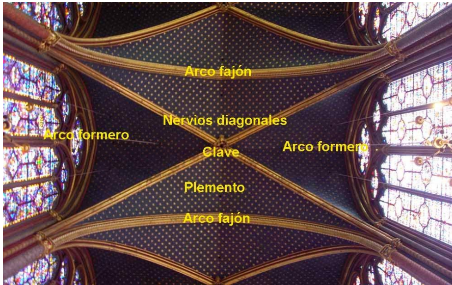
Figura nº 271. Elementos de la bóveda de crucería. Fuente: http://diccionarioartekonpedro.blogspot.com
