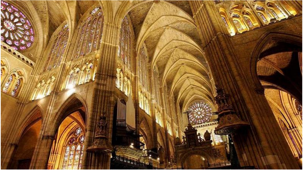
Figura nº 267. Arcos ojivales y bóvedas de crucería en el interior de la catedral de León. Fuente: https://es.m.wikipedia.org . Autor: Nacho Traseira
