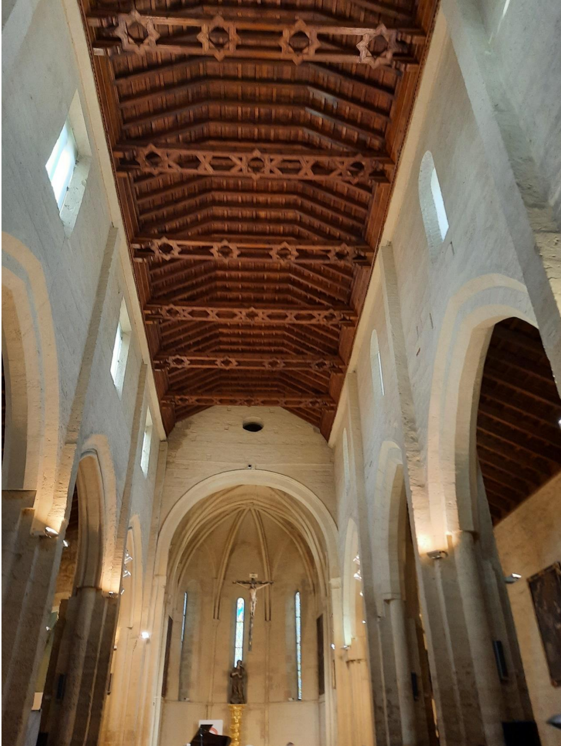
Figura nº 117. Imagen de la cubierta de par y nudillo de esta construcción fernandina. Fotografía de elaboración propia.
