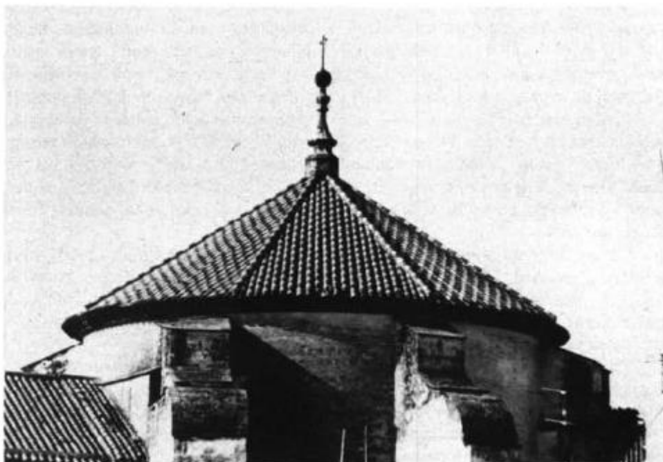
Lámina 5. Cilindro envolvente de la cúpula de la iglesia del Juramento de San Rafael en Córdoba.
