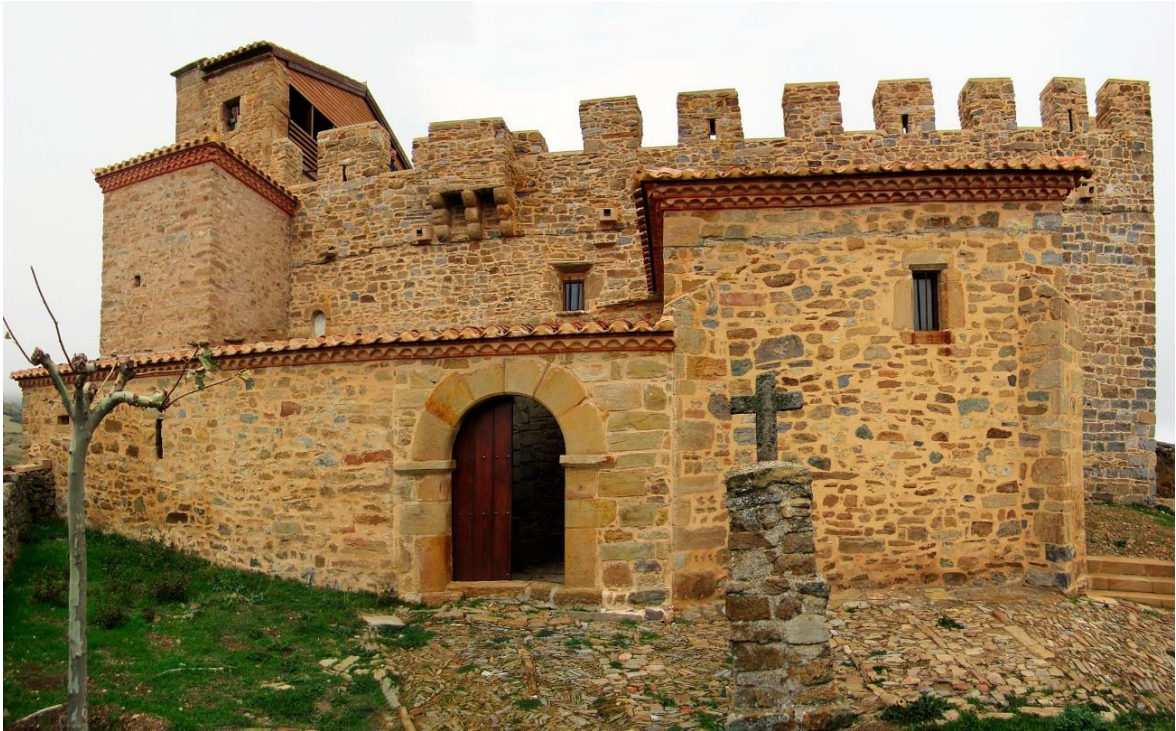
Figura nº 240. Iglesia y fortaleza N.ª Sra. del Collado (Valtajeros), con muros de mampostería. Fuente: https://www.google.com
