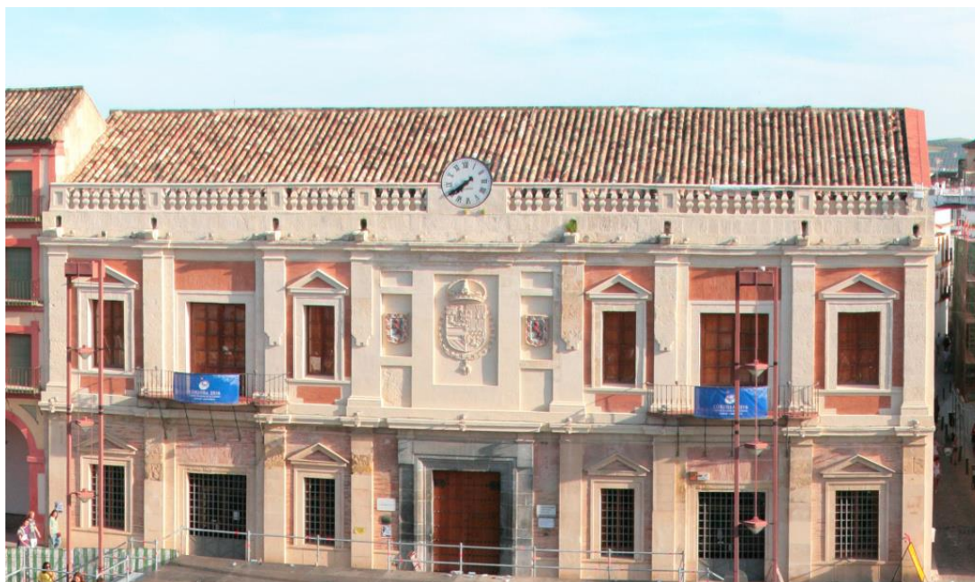
Figura nº 130. Edificio de la antigua cárcel de Córdoba en la plaza de la Corredera.
