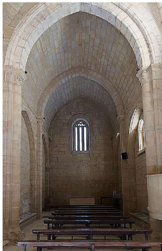
Figura nº 270. Arcos perpiños en bóveda apuntada. Ermita de Santa María de la Sorejana. (La Rioja). Siglo XIII. Fuente: https://www.arteguias.com
