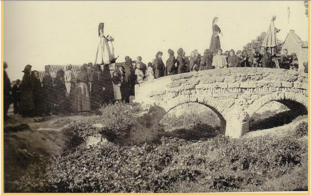
Figura nº 126. Puente sobre el arroyo de las Hormiguillas en Villafranca de Córdoba, estado en 1900. Foto del libro: El Alto Guadalquivir en el Recuerdo”
