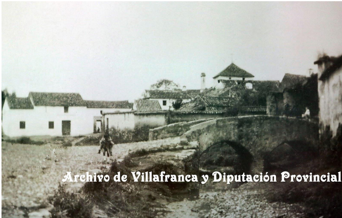
Figura nº 127. Puente sobre el arroyo de las Hormiguillas en Villafranca de Córdoba, finales del XIX. Fuente: http://historiagraficavillafranca.blogspot.com/2017/
