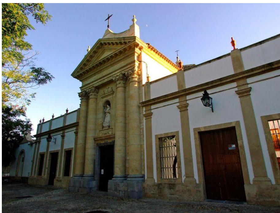
Figura nº 196. Fachada de la actual Ermita de la Salud. Fuente: https://www.tuttocordoba.com
