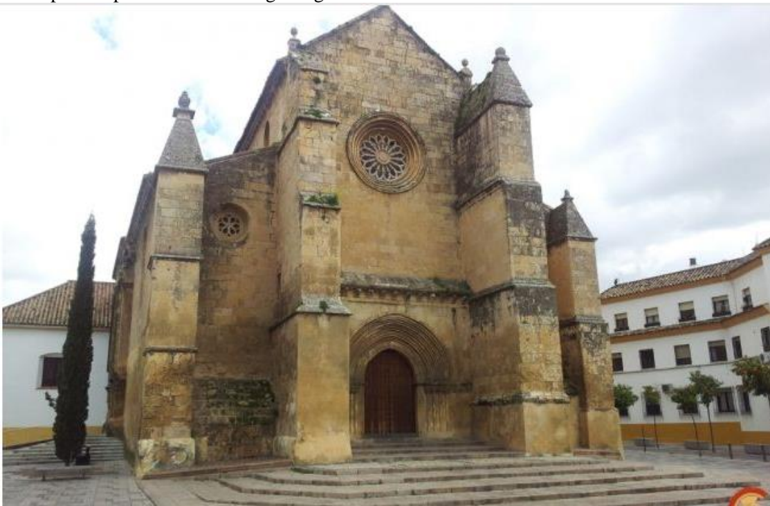
Figura nº 258. Frontal de la iglesia de Santa Marina de Córdoba. Fuente: https://www.rutasconhistoria.es
