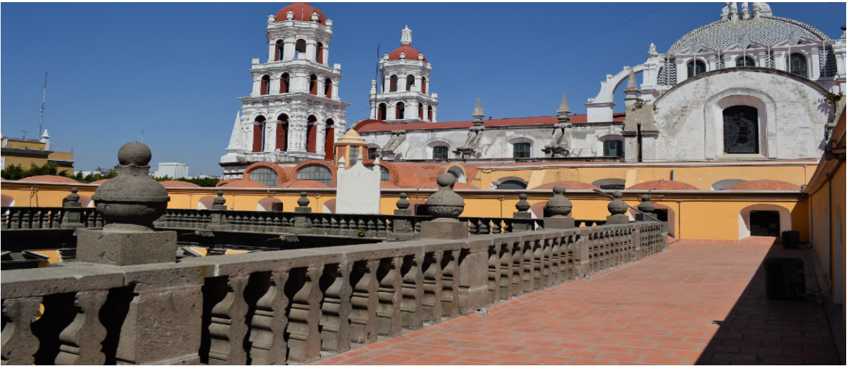
Fuente: https://cultura.buap.mx/cronicauniversitaria/historia-edificio-carolino-puebla-buap#_Toc16523125 . Azotea del primer patio del Edificio Carolino, con el templo de la Compañía al fondo
