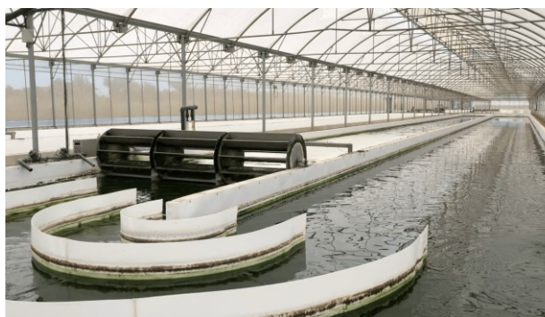
Figura 2. Raceway 1.000 m 2 de la Planta ÁGORA-SABANA.
