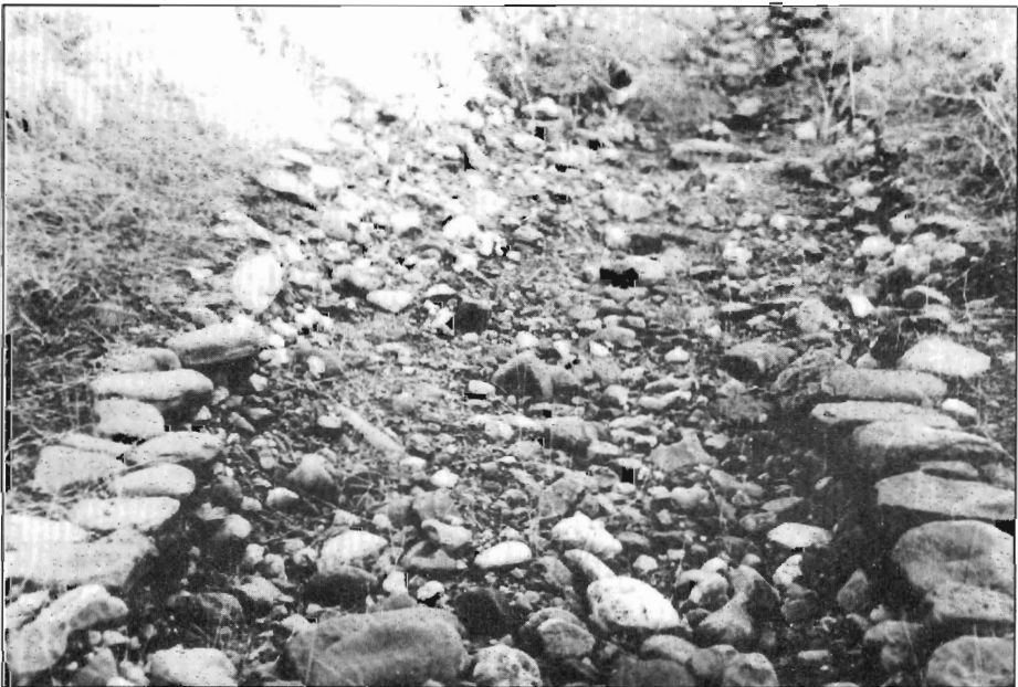
Lám. 4. Vía Corduba-Sisapo en las inmediaciones del castillo de Vioque. Detalle constructivo.
