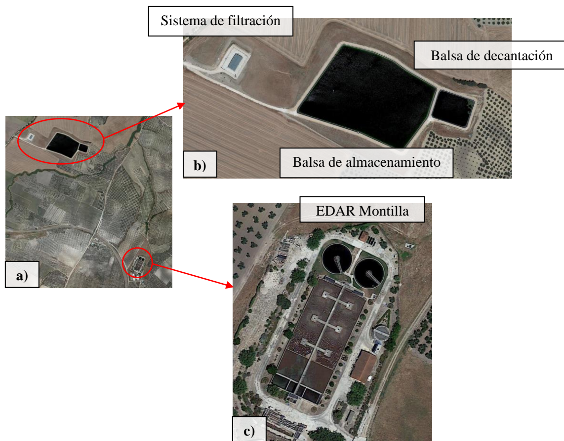
Figura 7. a) Vista general. b) Balsas y caseta de riego de la CR. c) EDAR de Montilla.
