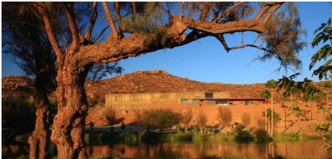
Fig. 3. Monte Xanic. Fotografía Sófoeles Hernández, Garduño Arquitectos.
